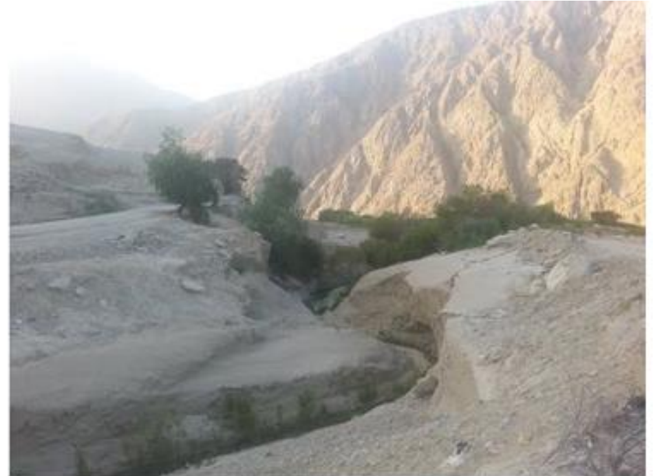
ZC-2. Quebrada Santa Catalina, por donde discurren flujos de detritos, excepcionalmente
