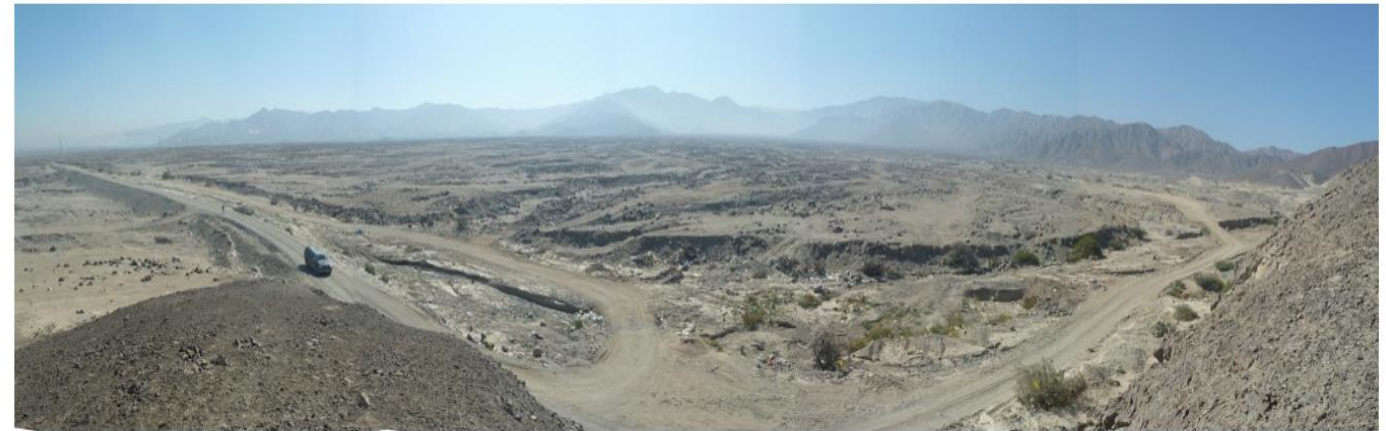
ZC-10. Quebrada Cansas, que se activa excepcionalmente y acarrea flujos de detritos. Se ha construido un dique transversal al cauce de la quebrada para encausar sus aguas.
