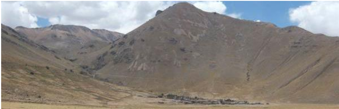
Foto 25. Sector en la quebrada Tarcapata – Chapacoco. Un próximo flujo excepcional podría afectar al poblado de Chapacoco y a la carretera a Orcopampa. (Tomado por Zavala, 2008).
