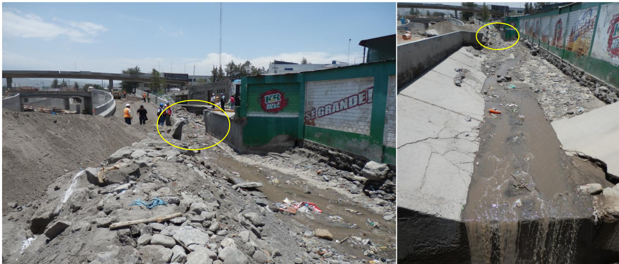
Foto 69. Vistas del estrangulamiento del cauce de la torrentera Venezuela, afectado por inundaciones de lodo, el depósito alcanzó hasta 1 m de altura.
