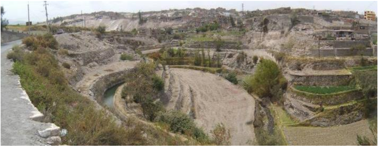
Foto 75. Flujo de detritos en la quebrada Peral, por la presencia de lluvias excepcionales afectaría canal de riego y terrenos de cultivo (tomado por Zavala, 2012).
