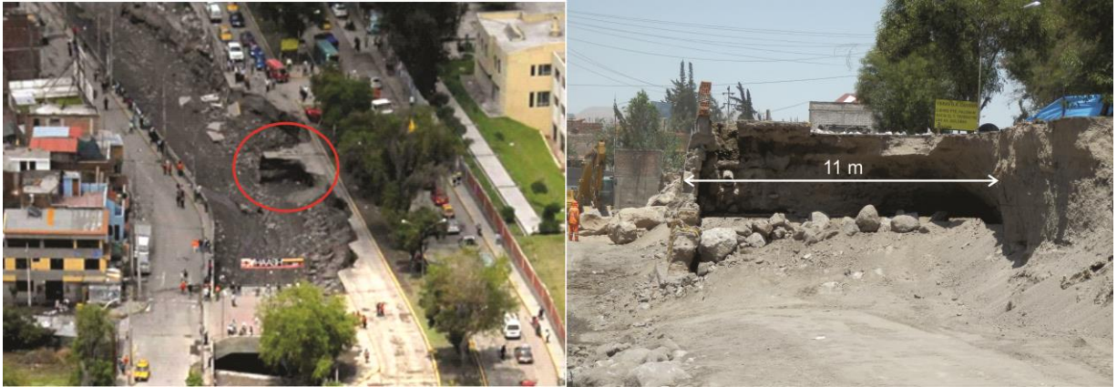
Foto 68. Erosión de toda la vía izquierda de la Av. Venezuela hasta la berma central, margen derecha de la Torrentera Venezuela afectó aprox. 135 m y un ancho de 11 m.
