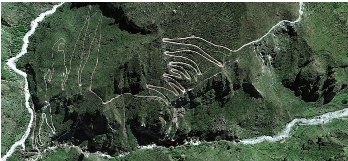
Figura 19. Tramo de carretera de acceso al poblado Puyca con muy alta susceptibilidad a derrumbes y caídas de rocas. Imagen Google Earth.
