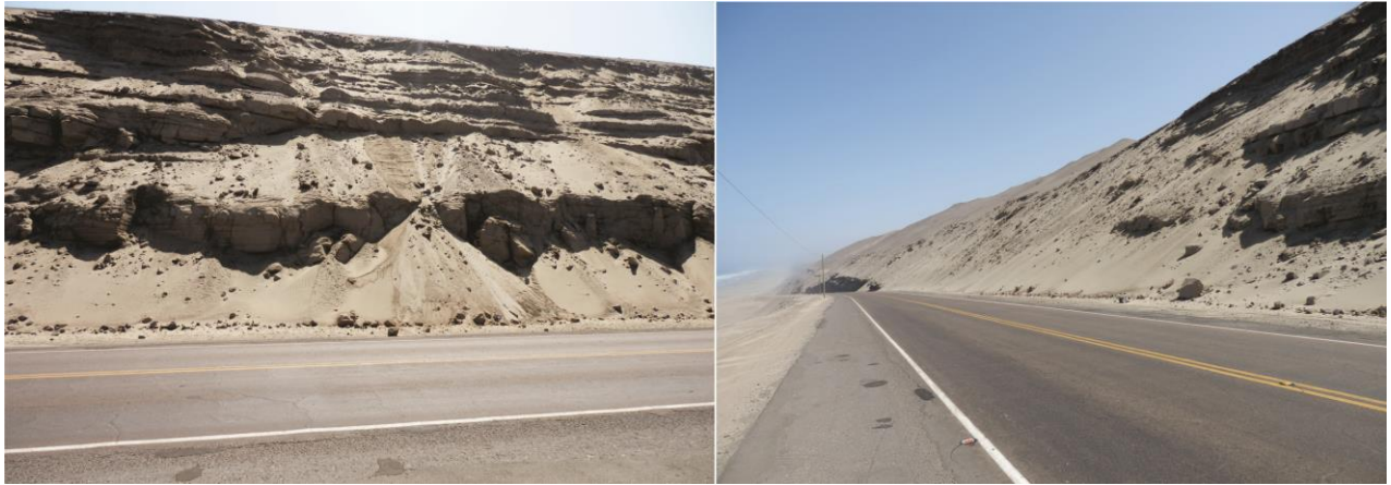
Foto 6. Derrumbes en depósitos eólicos y marinos en el km 648 de la carretera Panamericana Sur.
