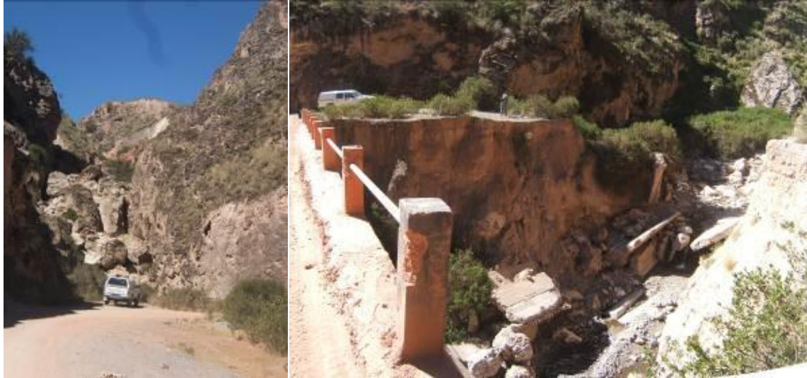
Foto 36. Carretera entre Huambo y Alto Sihuas. Derrumbe en la margen izquierda de la quebrada Mulapampa, erosión por el huaico generado, aguas abajo.
