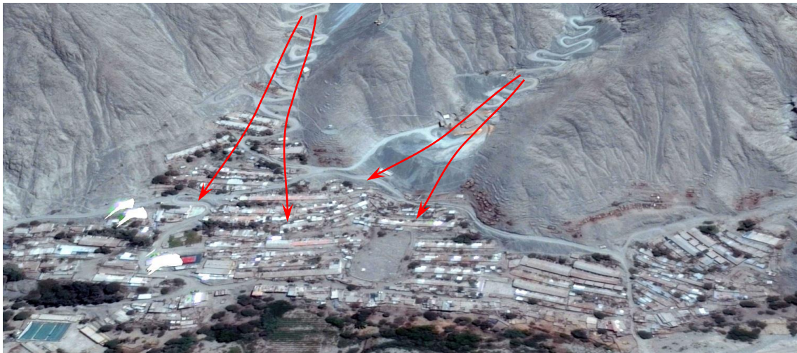
Figura 10. Poblado San Juan de Chorunga se ubica sobre un flujo antiguo, las flechas rojas indican la dirección de estos huaicos. Imagen Google Earth.
