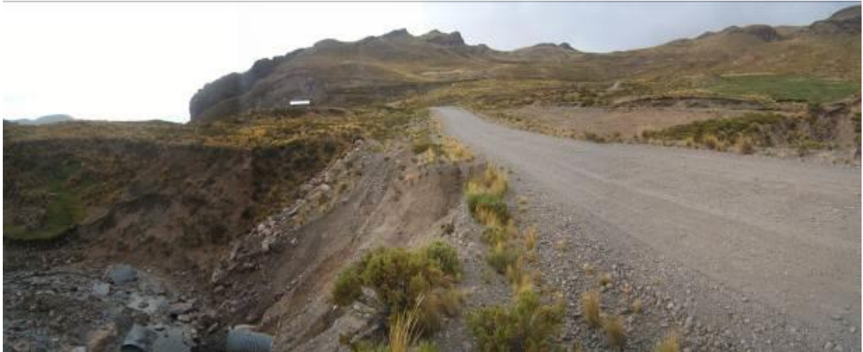
Foto 48. Deslizamiento de tierras en la quebrada Huacoto puede afectar torres de alta tensión y tramo de carretera Arequipa-Represa Condoroma. Tomado por Zavala (2008)
