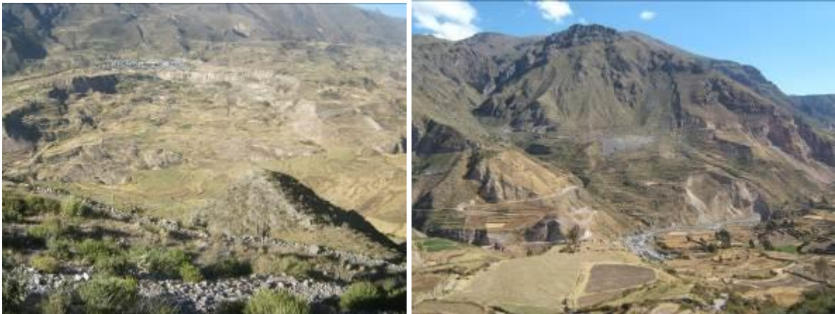
Foto 42. Deslizamiento rotacional de Maca-Cahacaña que afecta al distrito de Maca y a la carretera hacia Cabanaconde (foto izquierda). Reactivación de deslizamiento por construcción de carretera entre Maca y Lari (foto derecha). Tomado por Zavala (2008)
