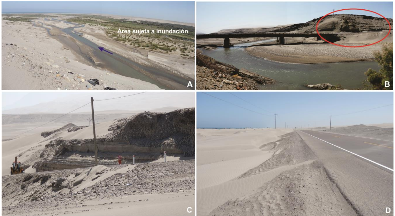
Foto 3. A) Área sujeta a inundación fluvial en ambas márgenes del río Yauca. B) Arenamiento en la margen izquierda del río Yauca. C) Derrumbes en talud superior de la carretera Panamericana Sur en depósitos de conglomerados y de arena. D) Invasión de dunas en carretera Panamericana Sur, km 578.
