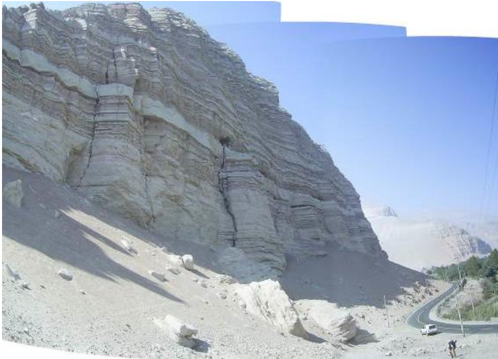
Foto 33. Derrumbes y agrietamientos en el sector Recodo Cerro que afectan a la carretera Aplao – Huancarqui (tomado por Zavala, 2008).
