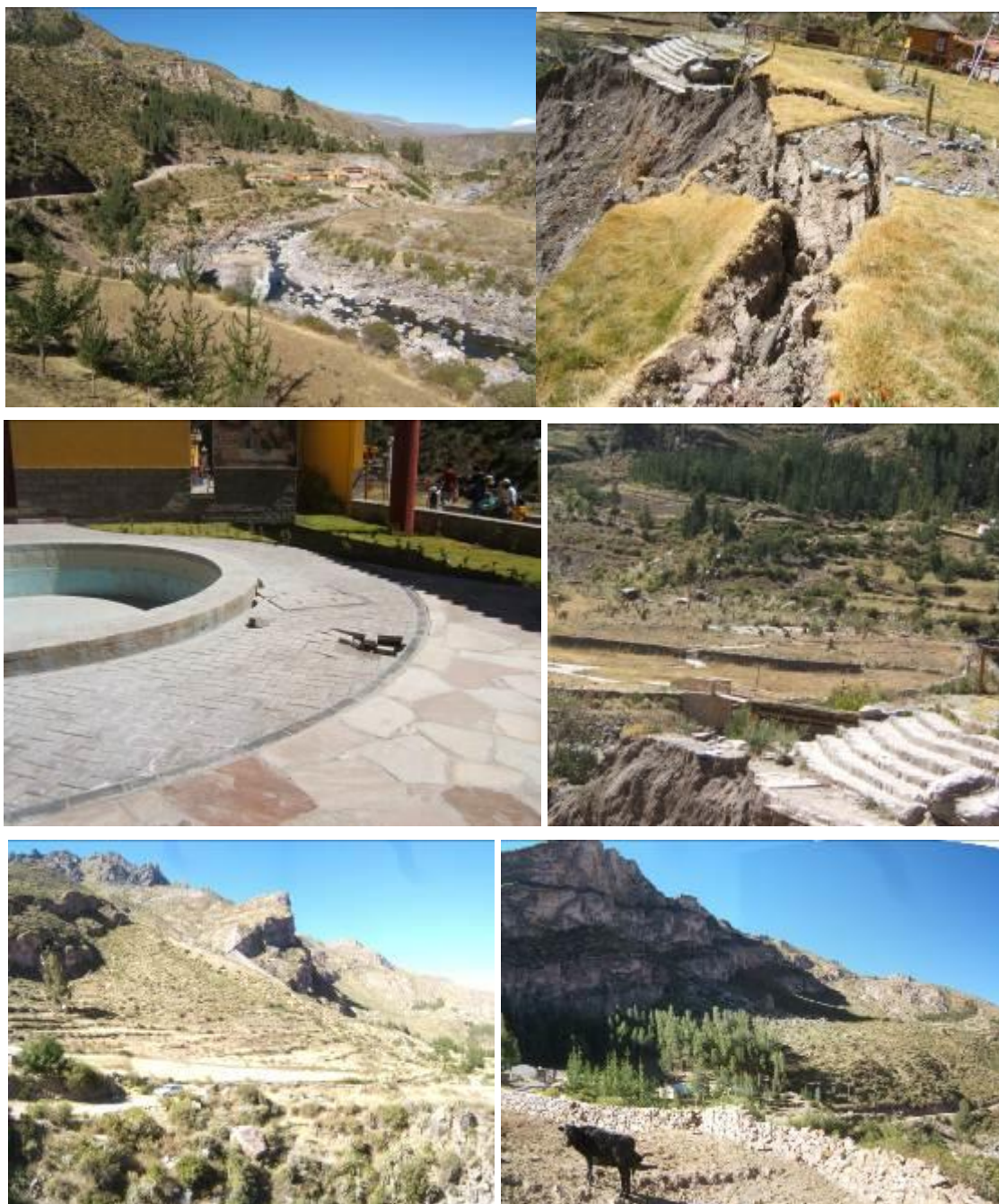
Foto 45. Vistas panorámica y de detalle de los sectores de Baños Termales "La Calera", Pucaloma y Hospedaje el Bosque. Se ven afectados por deslizamientos, caídas de rocas y flujos que afectan la infraestructura del lugar y a los vehículos que transitan por la zona. Tomado por Zavala (2008)
