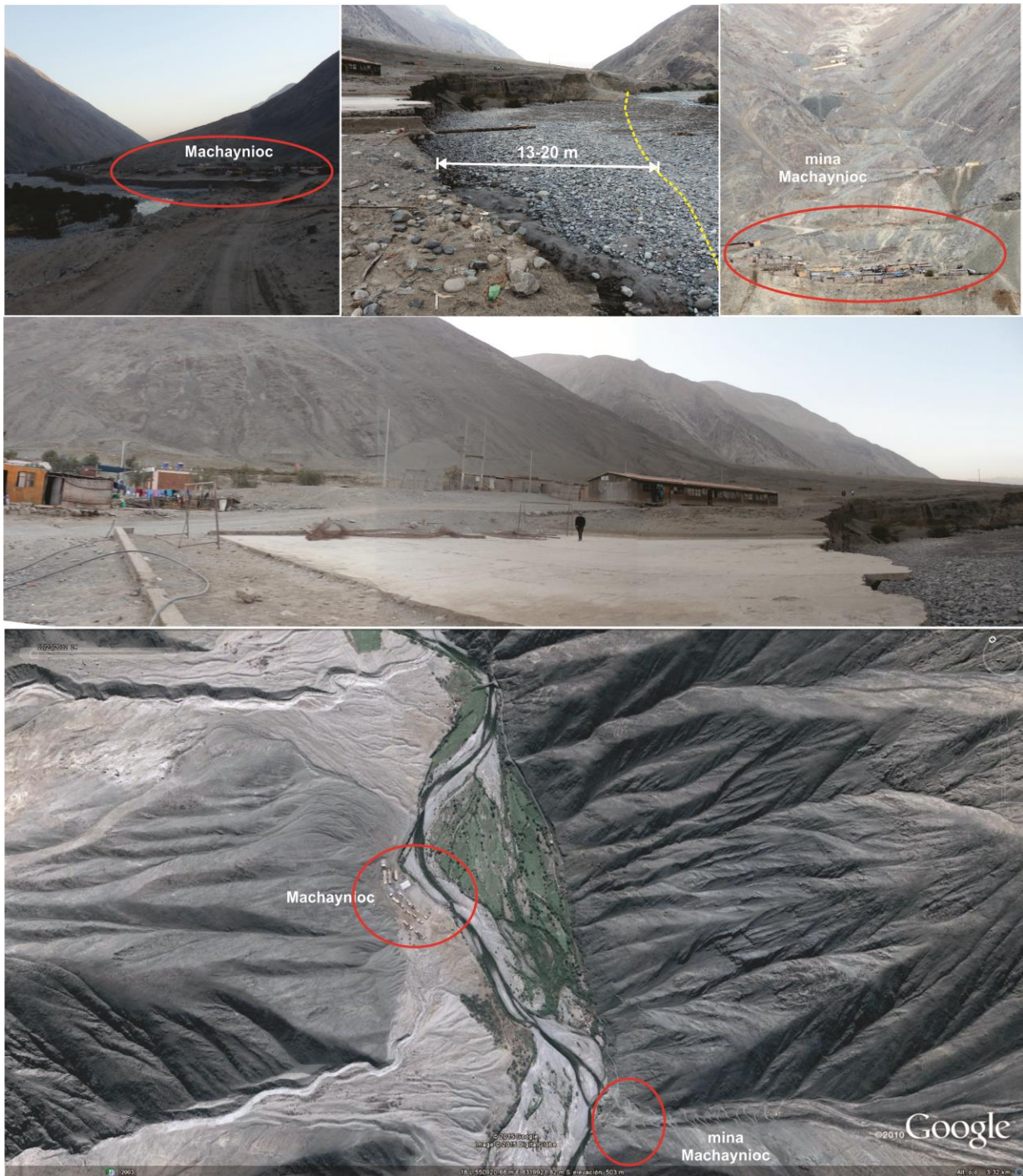
Foto 1. Vistas del sector Machaynioc afectado por erosión fluvial en la margen derecha del río Machaynioc, el poblado se encuentra sobre depósitos de flujos antiguos como se muestra en la imagen del Google Earth.
