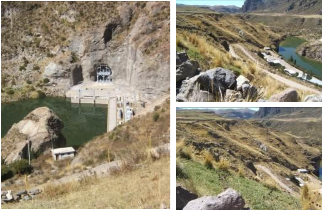
Foto 46. Deslizamiento rotacional que en el año 2005 produjo asentamientos de terrenos que afecto casa de maestranza de la bocatoma de Tuti. Tomado por Zavala (2008)
