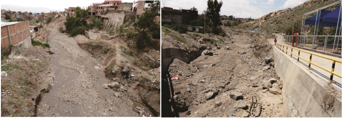
Foto 66. Flujo de detritos en la torrentera y derrumbes en ambas márgenes de la torrentera, cabecera de la torrentera Venezuela, sector San Juan XXIII, confluencia de ramal I y II.
