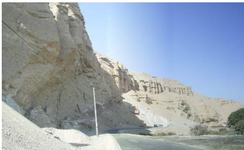
Foto 32. Derrumbes del Cerro Huancarqui afectan a aproximadamente 500 m de carretera desde la salida del puente de Aplao (tomado por Zavala, 2008).
