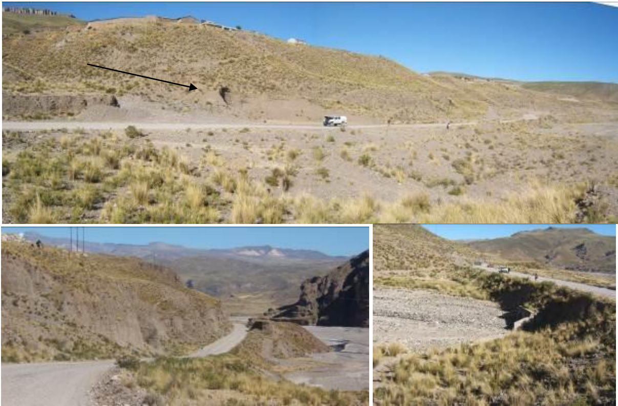
Foto 47. Sector de Callalli. Tramo de carretera de unos 600 m que se ve afectado por derrumbes y huaicos. Tomado por Zavala (2008)
