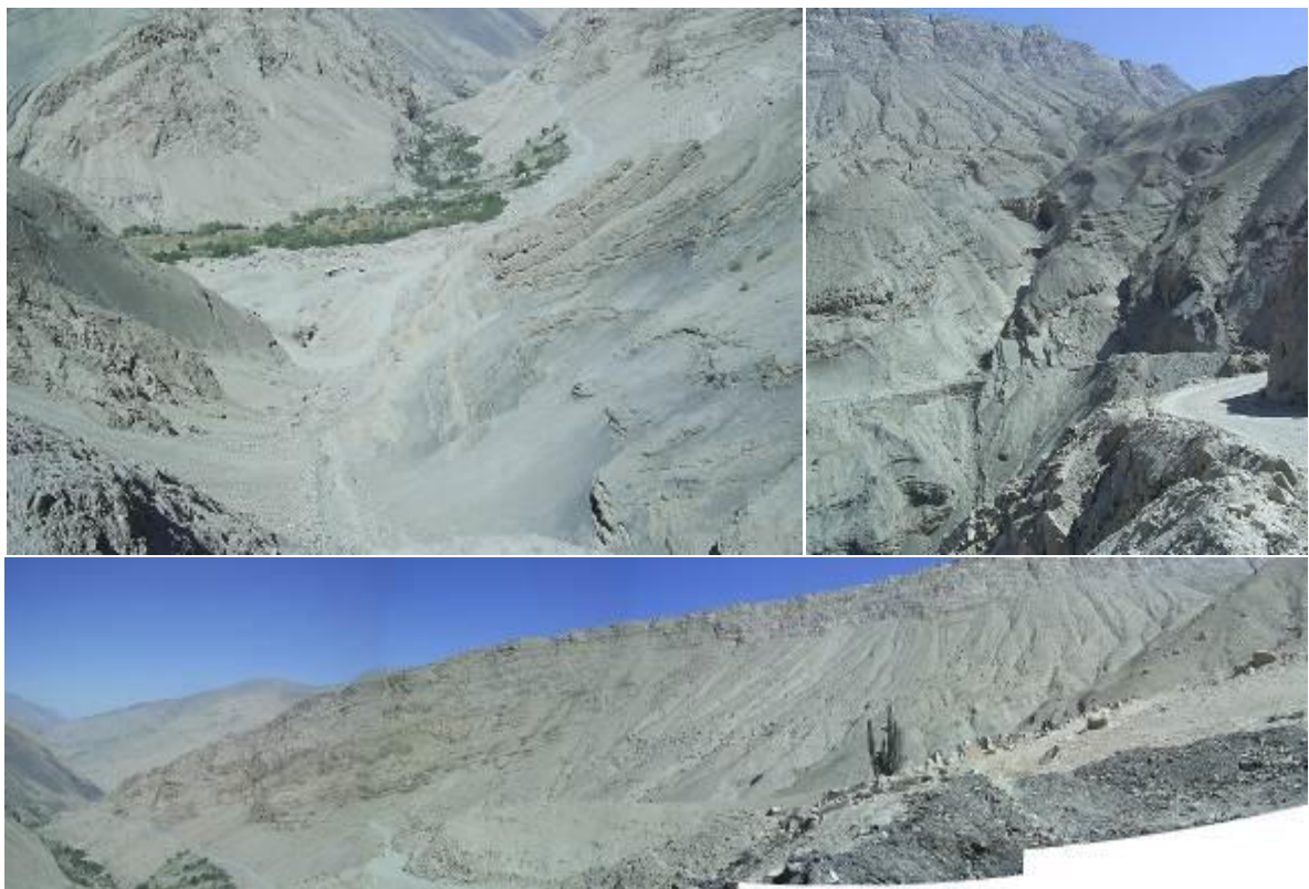
Foto 27. Erosión de laderas que han afectado un tramo de carretera en más de un kilómetro en el sector Lomas de Mamas (tomado por Zavala, 2012).
