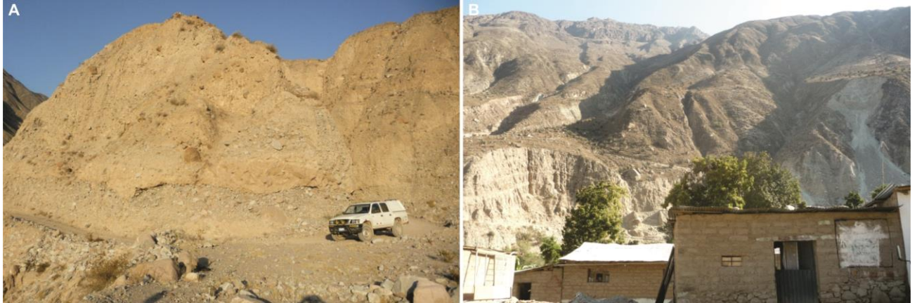
Foto 20. A) Carretera a Chichas – Yachanguillo, a la altura del Km 7+120 afectada por derrumbes y huaicos, se observa el substrato de mala calidad. B) Derrumbes y erosión en cárcavas en el sector Chichas.
