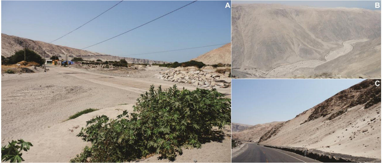
Foto 12. Quebrada Pescadores, todos los años acarrea huaicos y obstruye vía, en el km 755 de la carretera Panamericana Sur.
