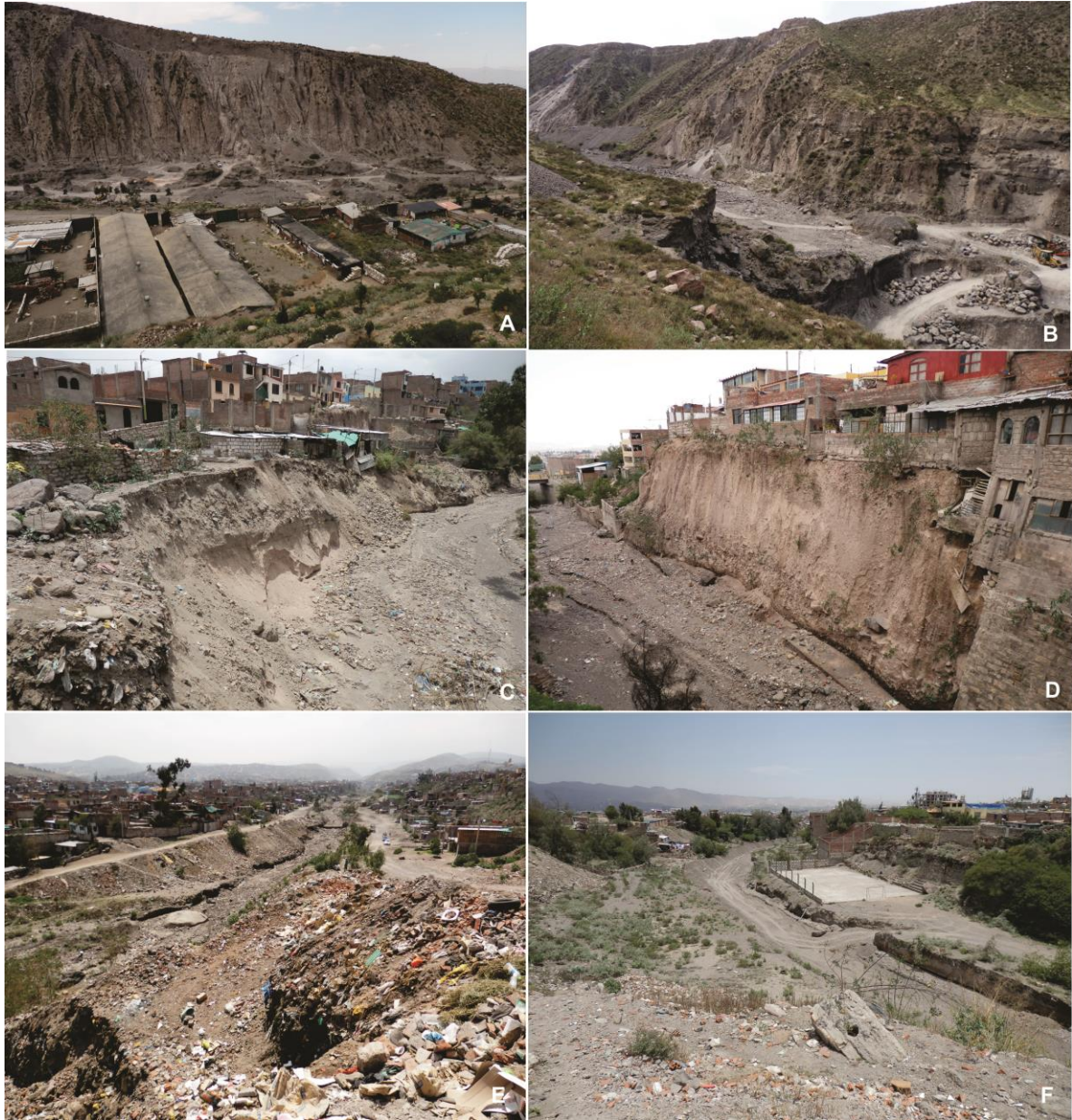
Foto 72. A) Erosión en cárcavas y derrumbes en ambas márgenes de la quebrada San Lázaro (parte alta), aportan material suelto al cauce de la quebrada. B) Presencia de canteras en el cauce de la quebrada San Lázaro, acumulan material suelto. C y D) Viviendas se encuentran al borde del acantilado formado en la quebrada San Lázaro, algunas ya han colapsado. E). Desmonte y basura acumulada en la parte alta de la quebrada San Lázaro. F) Plataforma deportiva en terraza baja de la quebrada San Lázaro.
