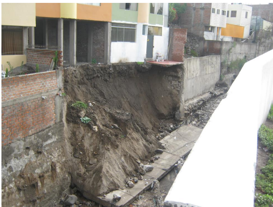
Foto 73. Vivienda colapsada en la margen derecha de la quebrada San Lázaro debido al incremento del caudal por efecto de las lluvias excepcionales del 08/02/2013.
