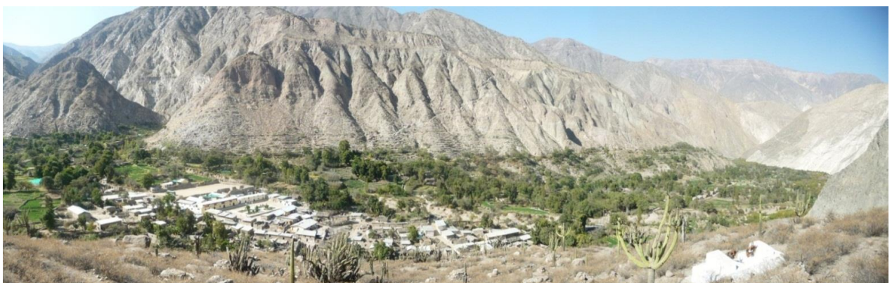
Foto 21. Vista aguas abajo del poblado Chichas en la margen derecha del río, en la zona se observa intensa erosión en cárcavas que en época de lluvias intensas discurren huaicos a través de ellas (Tomado por Medina, 2013).
