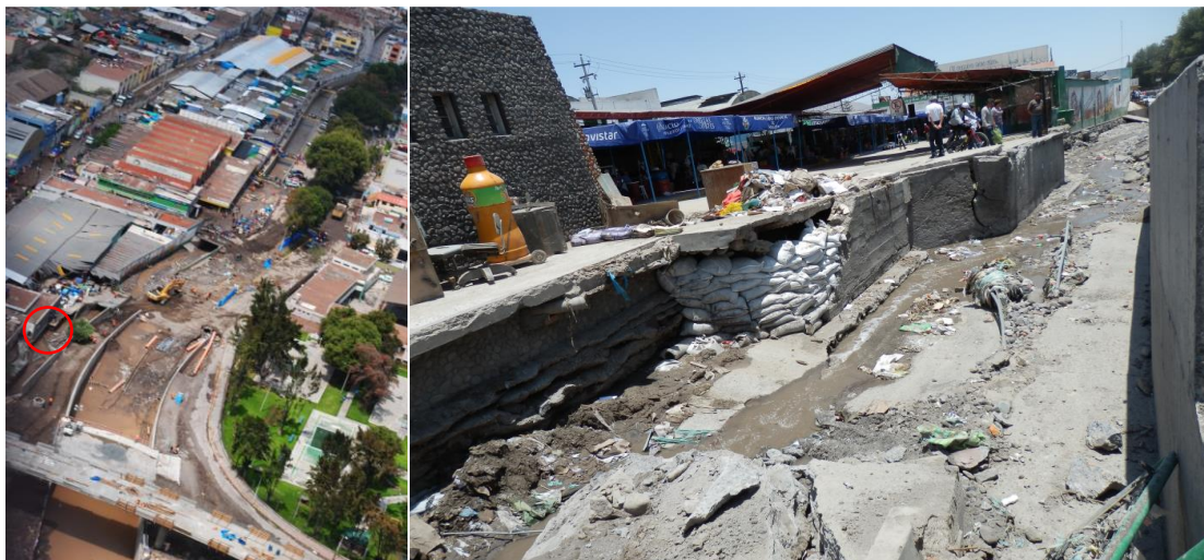
Foto 70. En la izquierda, Vista aérea del sector Terminal Pesquero, se observa la reducción del cauce en forma escalonada de 6 a 3 m de ancho. En la derecha, ampliación de la vista, erosión en la margen izquierda de la torrentera Venezuela.
