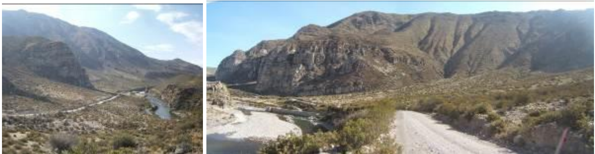
Foto 26. Laderas del cerro Pichihua con erosión en cárcavas y flujos de detritos que afectan periódicamente un tramo de la carretera Andahua-Orcopampa (tomado por Zavala, 2008).
