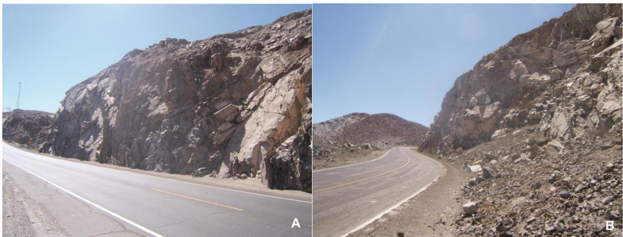
Foto 60. A) Taludes propensos a caída de rocas y derrumbes en tramo de la variante de Uchumayo. B) Rocas fracturadas que pueden generar caídas de rocas. Antigua carretera Panamericana (tomado por Zavala, 2012).
