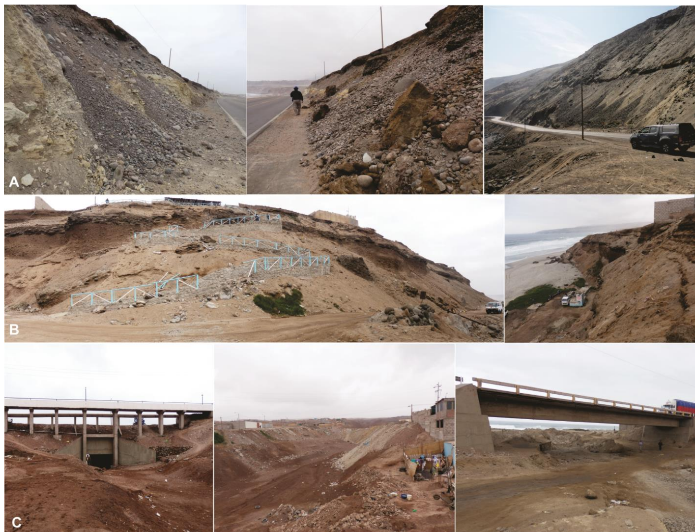
Foto 5. A) Derrumbes en talud superior de la carretera Panamericana con presencia de asentamientos en plataforma de carretera Panamericana Sur Km 615+100 al km 616+200. B) Sector de La Aguadita afectado por derrumbes y caída de rocas que afectaron camino peatonal a la playa. C) Quebradas Cementerio y Chala, aguas arriba de la quebrada Cementerio se ha obstruido el cauce de la quebrada con rellenos. Tomado el 03 de octubre del 2013, después del sismo del 25/09/13.
