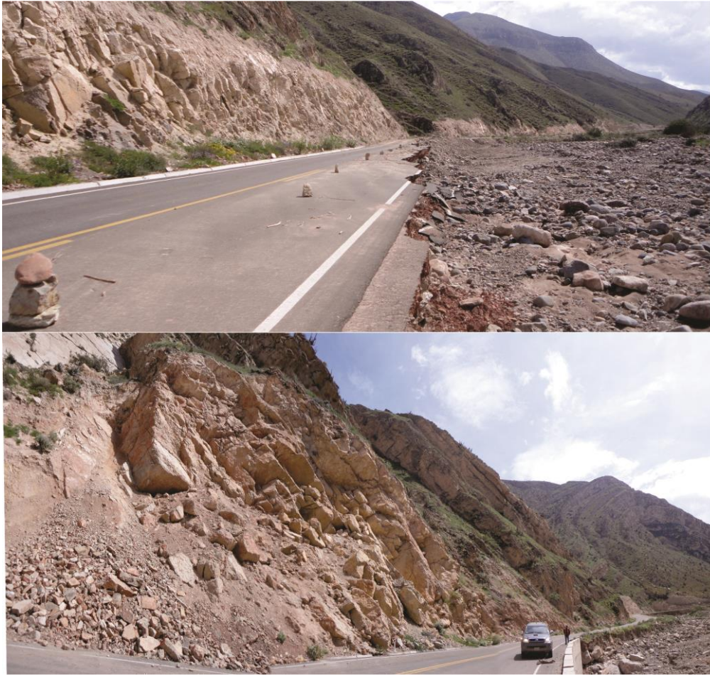
Foto 17. Quebrada Liquirca, aumentó su caudal en el periodo lluvioso 2012, generando erosión fluvial en la margen derecha, afectando tramo carretero Yura-Huanca en 100 m (Km 9+720). Tomado por Zavala, 2008.
