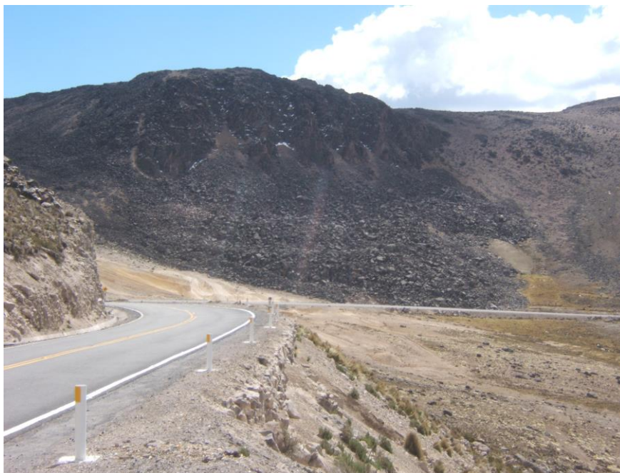
Foto 49. Caída de rocas en la Carretera Chivay Km 53+000. Tomado por Zavala, 2008.
