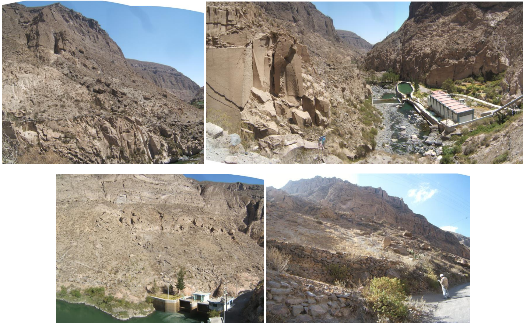
Foto 80. Laderas y taludes propensos a caída de rocas y derrumbes en el cañón del río Chili (ambos márgenes) que obstaculizarían el tránsito y afectan las centrales hidroeléctricas en Charcani (tomado por Zavala, 2012).
