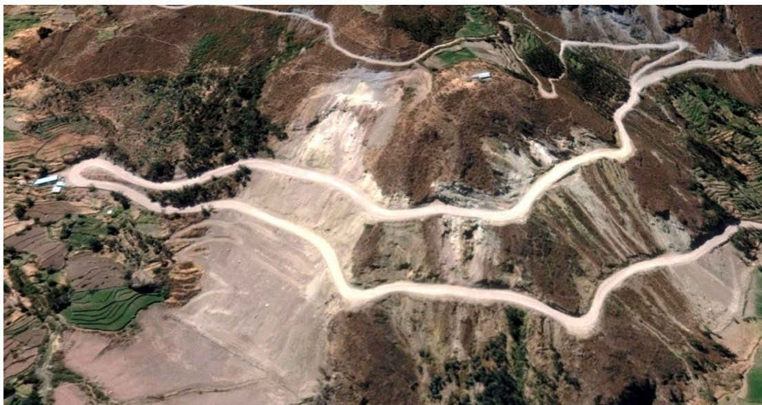
Figura 18. Carretera de acceso entre Cotahuasi y Chuquibamba (Km 8+100) afectada y susceptible a derrumbes por corte de talud para su construcción. Imagen Google Earth (Medina et al., inédito).
