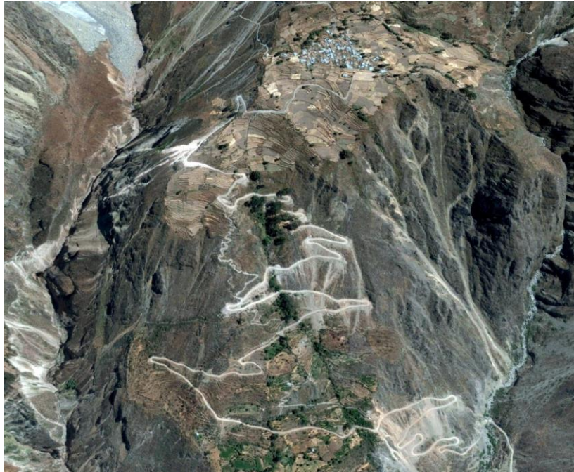
Figura 15. Poblado de Huarhua asentada sobre depósito coluvio-deluvial susceptible a proceso de erosión en cárcava y deslizamientos. También se observa carreta de acceso que podría ser afectada por derrumbes. Imagen Google Earth (Medina et al., inédito).
