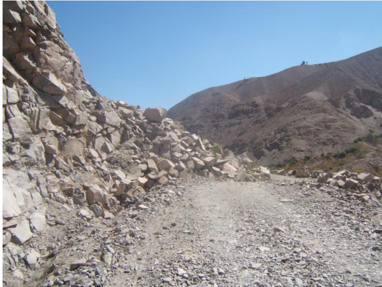
Foto 58. Derrumbes en el río Vítor (margen izquierda) interrumpiendo camino rural (tomado por Zavala, 2012).
