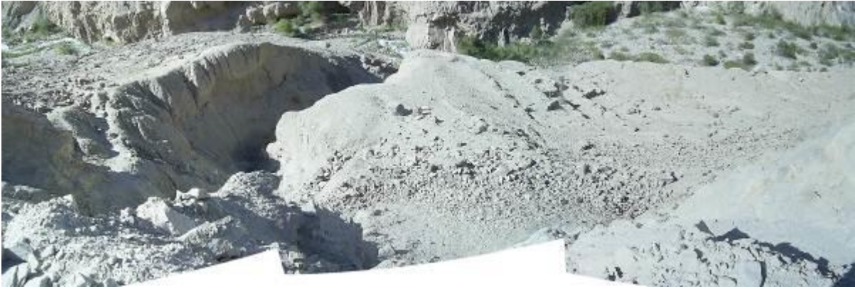
Foto 28. Vista del sector de Andamayo. Cárcavas y canales que se activan con lluvias y afectan un tramo de la carretera de acceso a Tipan y Viraco (tomado por Zavala, 2008).
