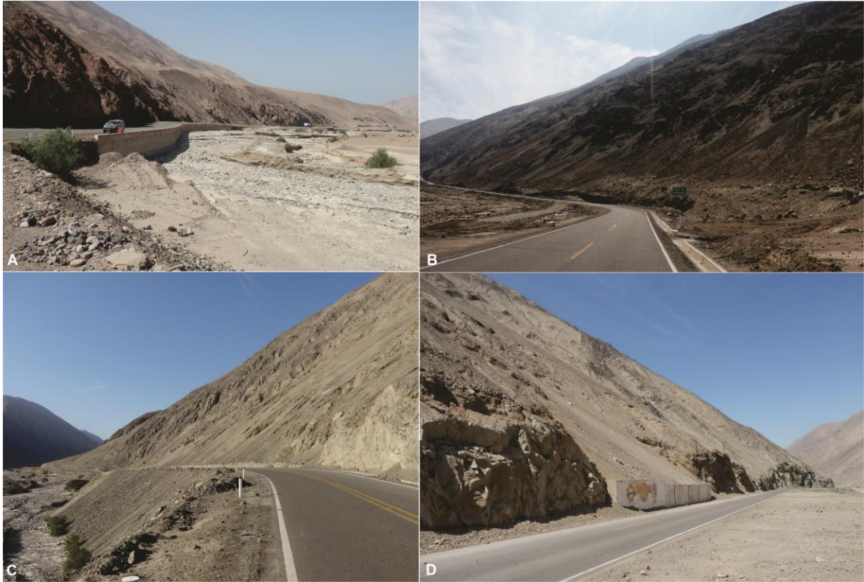
Foto 8. A) Erosión fluvial en la margen izquierda del río Atico, en el km 11+420 de la carretera Atico-Caraveli. B, C y D) Derrumbes en talud superior de carretera Atico-Caraveli, en los km 22+250, km 18+320, km 21+300 respectivamente.
