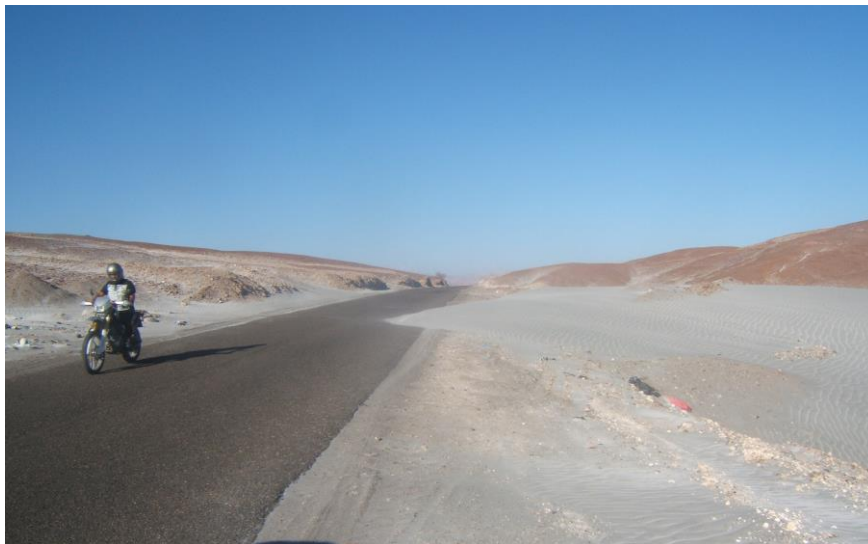
Foto 56. Arenamiento en Pampa Repartición que afecta carretera La Cano (tomado por Zavala, 2012).
