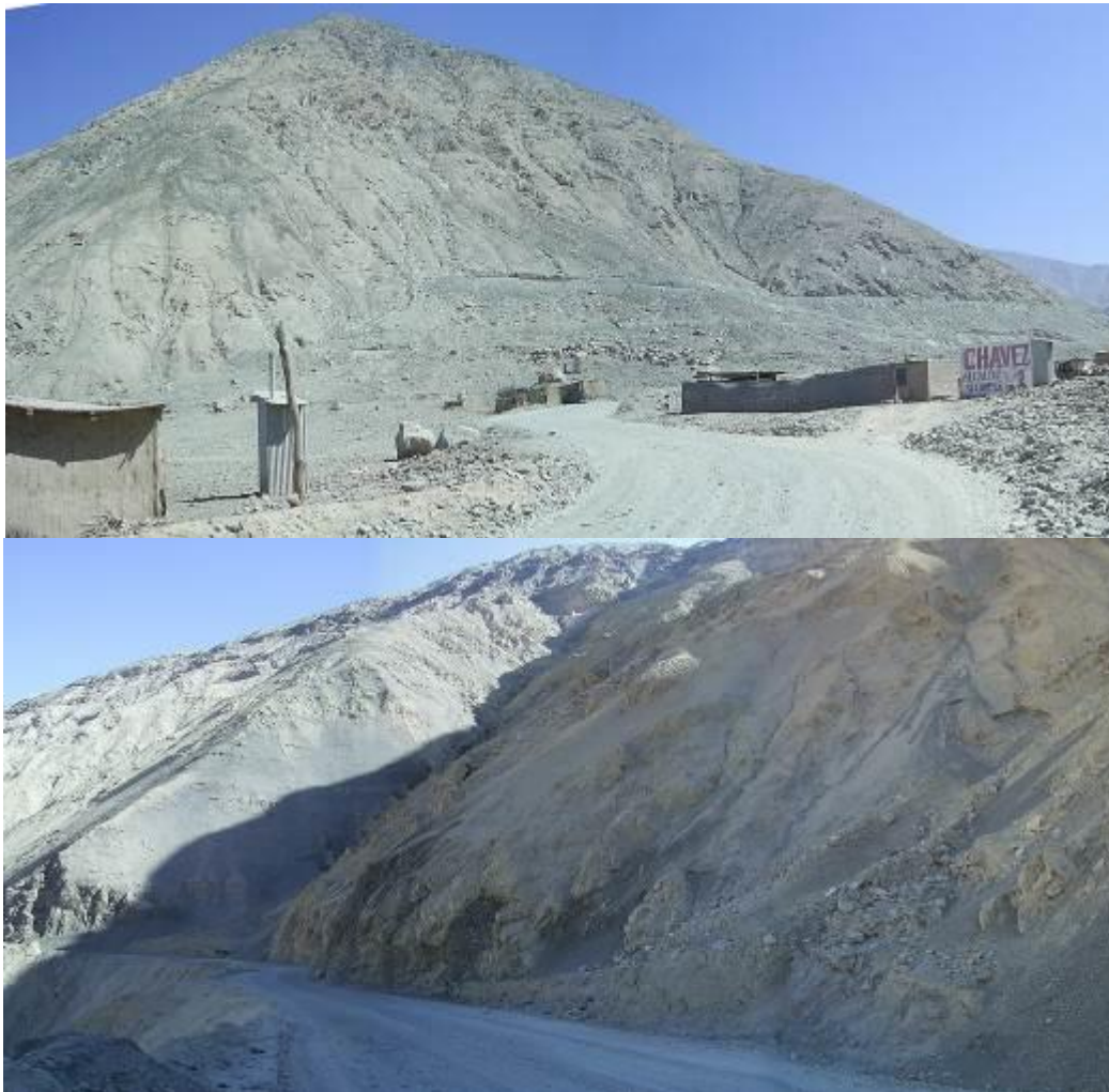
Foto 29. Sector de Andamayo. Tramo de carretera de acceso a Tipan y Viraco que en épocas de lluvia es intransitable (tomado por Zavala, 2008).
