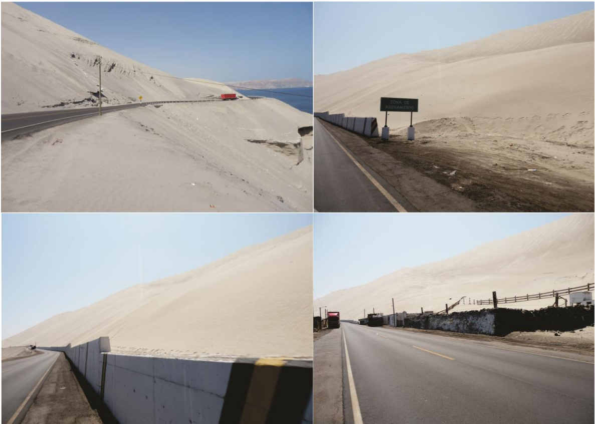
Foto 10. Vistas de arenamiento en cerro de Arena, en el km 743 de la carretera Panamericana Sur.
