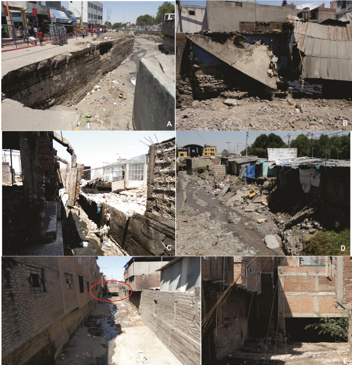
Foto 67. A) Colapso de muros de contención en la margen izquierda de torrentera, con pérdida de plataforma de la calle Virgen del Pilar, descubriendo un muro antiguo a más de 1 m detrás del actual con 17 m de ancho. B) Colapso de muros de los puestos del mercado del Altiplano. C) El cauce de la torrentera se ha estrechado a 4,54 m de ancho por construcción de edificaciones, por efecto del flujo socavó los cimientos del muro de contención en la margen izquierda generando el colapso de las columnas de la fábrica textil y rebose en ambas márgenes, en el pasaje Victoria; el puente en forma de arco a 11 m aguas abajo tiene un ancho de 3,78 m, el cual estranguló aún más la torrentera. D) Intersección de la Av. Venezuela con el pasaje Jacinto Ibañez, frente a la Urb. Juan El Bueno, se encuentran ubicadas 6 viviendas y un total de 20 personas que habitan dicho espacio, en la margen derecha de la torrentera, pese a que se realizó la limpieza del cauce es evidente que las viviendas han avanzado hacia el cauce de la torrentera. Al incrementar el caudal de la torrentera el 08 de febrero se represó debido a un obstáculo en el puente Vidaurrázaga (letrero de centro comercial), al desfogar erosionó 93 m en su margen derecha. E) Cauce de torrenteras se encuentra invadida por edificaciones que por ganar terreno han construido por encima de la torrentera.
