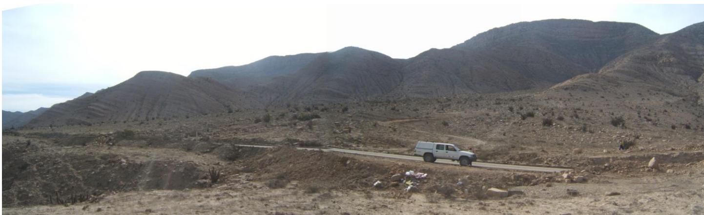
Fotos 81 y 82. Flujos de detritos excepcionales que afectan tramo de carretera Yura-Huanca-Lluta, así como acceso a las canteras de la minas de calizas de Cementos Yura (tomado por Zavala, 2012).
