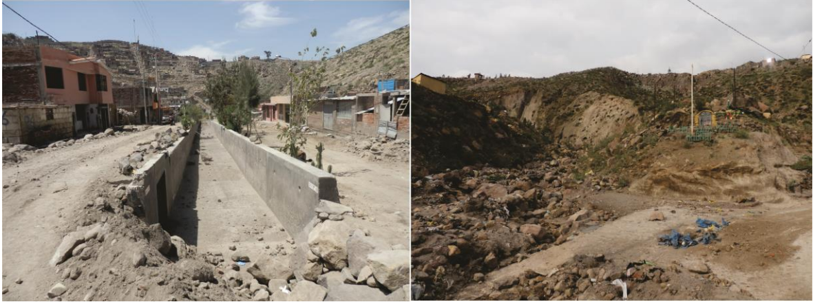
Foto 64. Cabecera de la torrentera Venezuela, presenta derrumbes, caída de rocas, erosión de laderas que época de lluvias excepcionales como las del 08/02/2013 discurren huaicos por las laderas con material suelto, aportando material al cauce de la torrentera, además del mal diseño de obras como en la foto del lado izquierdo en el sector Mariano Bustamante, Villa Alto Cenepa, y derrumbes y huaicos en el A.H Villa El Triunfo.
