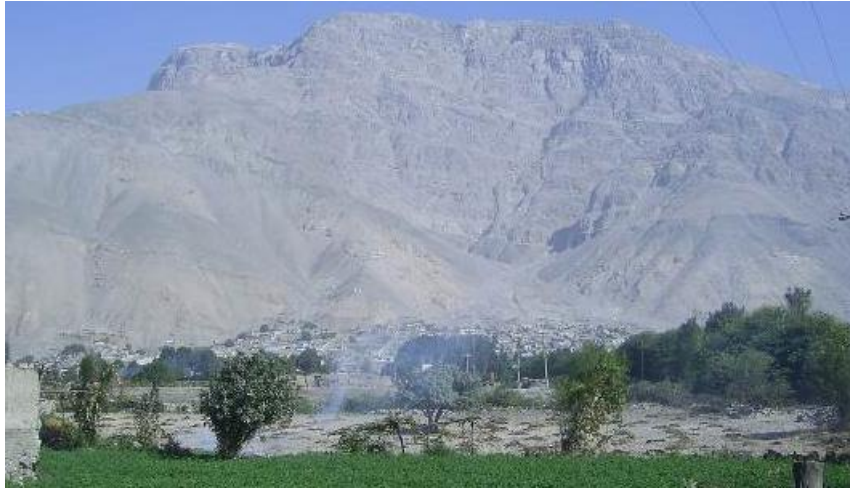
Foto 30. Viviendas del distrito de Aplao se ubican sobre un abanico por donde constantemente cae material de las laderas superiores (tomado por Zavala, 2008).
