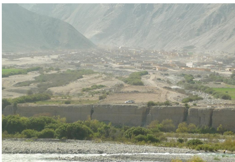
Foto 15. Vista panorámico donde se observa que el poblado de Secocha está asentado sobre depósito de flujo de detritos en forma de abanico. Tomado por Medina, 2013.
