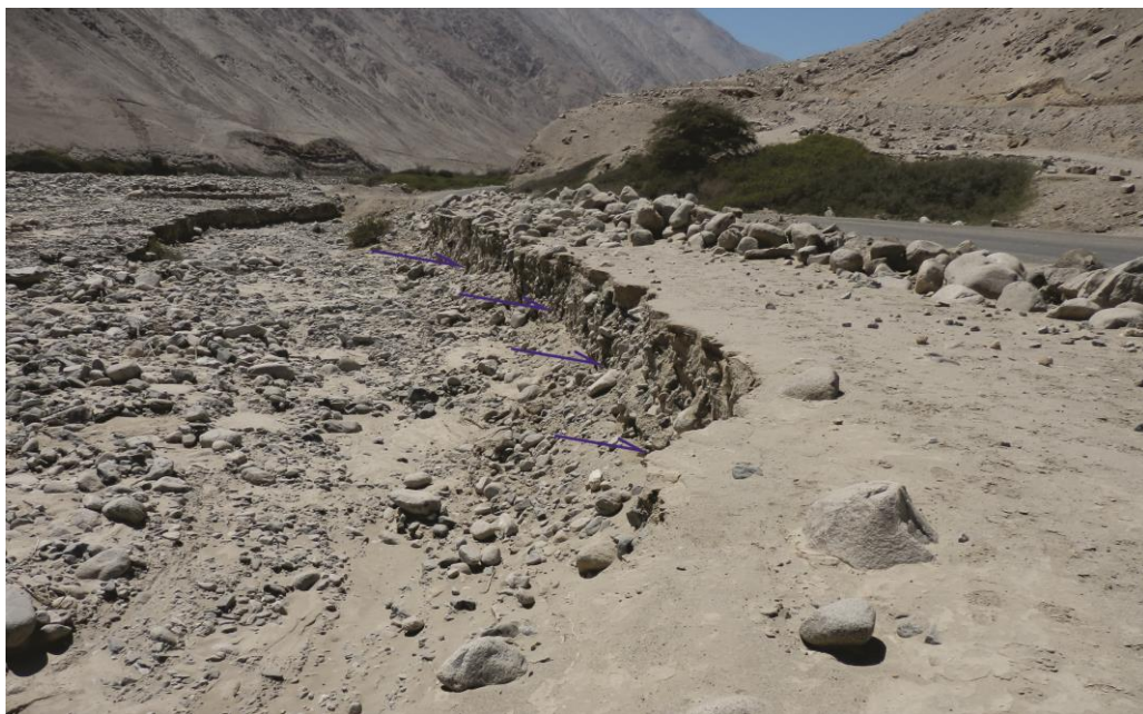
Foto 4. Erosión fluvial en el km 32+200 de la carretera Yauca-Laytaruma, en la margen izquierda de la quebrada Acaville.
