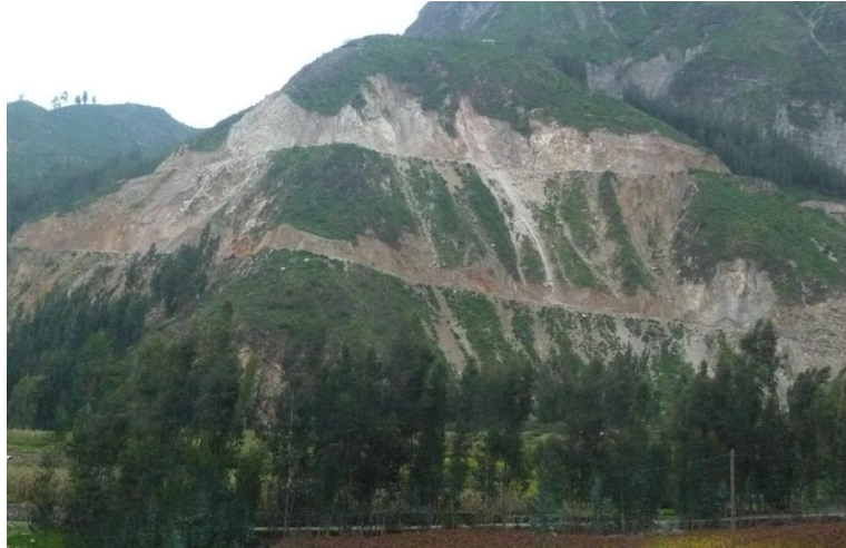
Foto 24. Zona de derrumbes en el tramo de carretera Cotahuasi-Chuquibamba, Km 8+100 (tomado por Medina, 2013).
