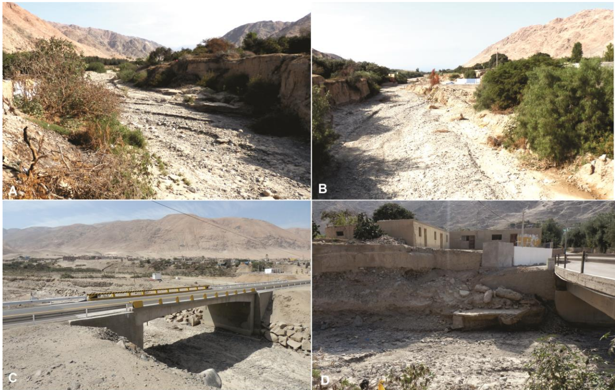
Foto 9. A) Erosión fluvial en la margen derecha del río Atico, B) Erosión fluvial en la margen derecha del río Atico, C) Puente La Florida, D) Puente Atico presenta daños en estribo derecho del puente.
