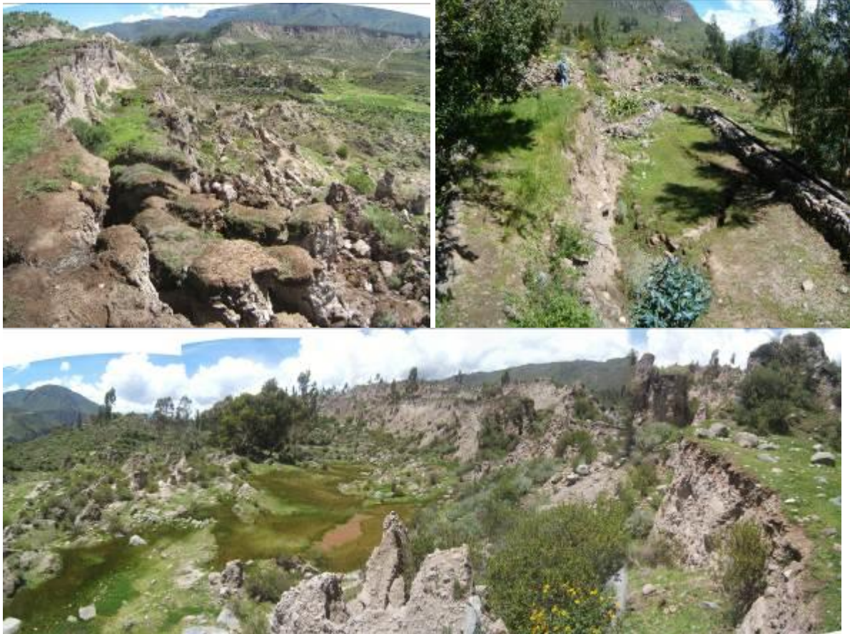
Foto 43. Vistas del deslizamiento de Maca-Chacaña. Tomado por Zavala (2008)
