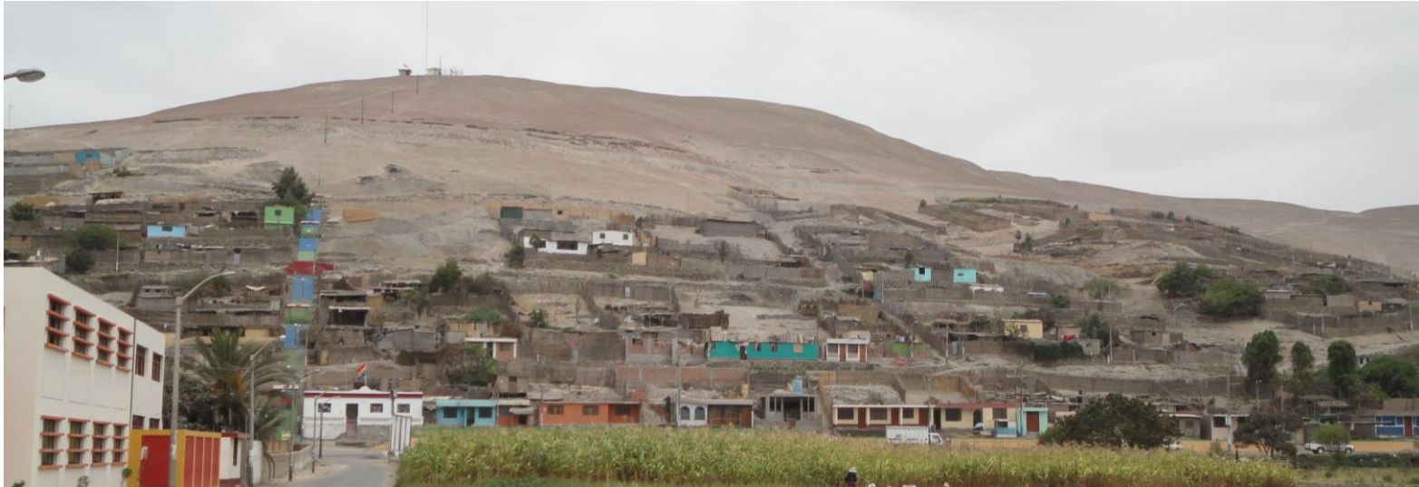
Foto 86. Sector El Arenal, ladera cubierta por viviendas (tomado por Zavala, 2012).
