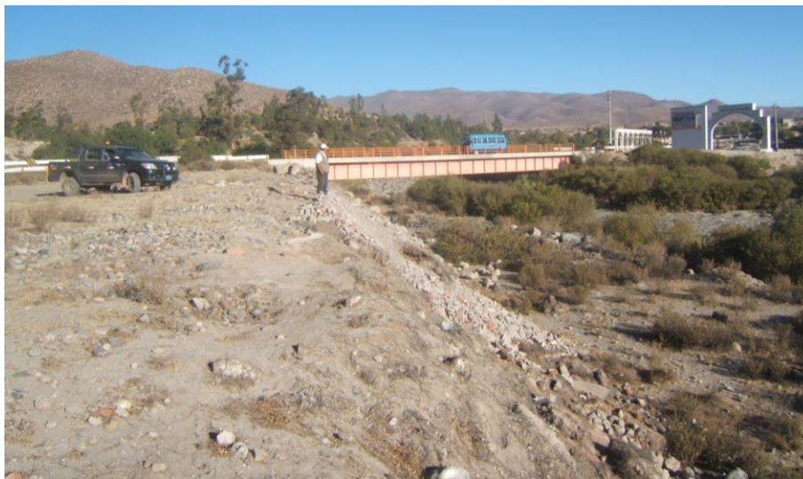
Foto 61. Río Yarabamba. Botadero de desmonte en la margen derecha que estrecha su cauce (tomado por Zavala, 2012).
