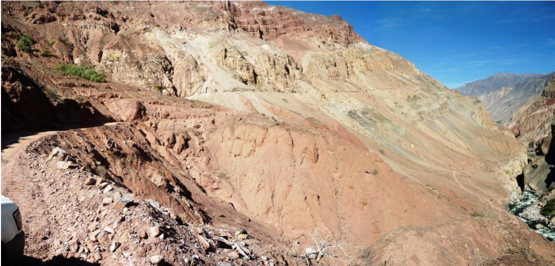
Foto 23. Tramo de carretera de acceso entre los poblados de Cotahuasi y Velinga susceptible a la ocurrencia de derrumbes, flujos y cárcavas en periodo lluvioso.
