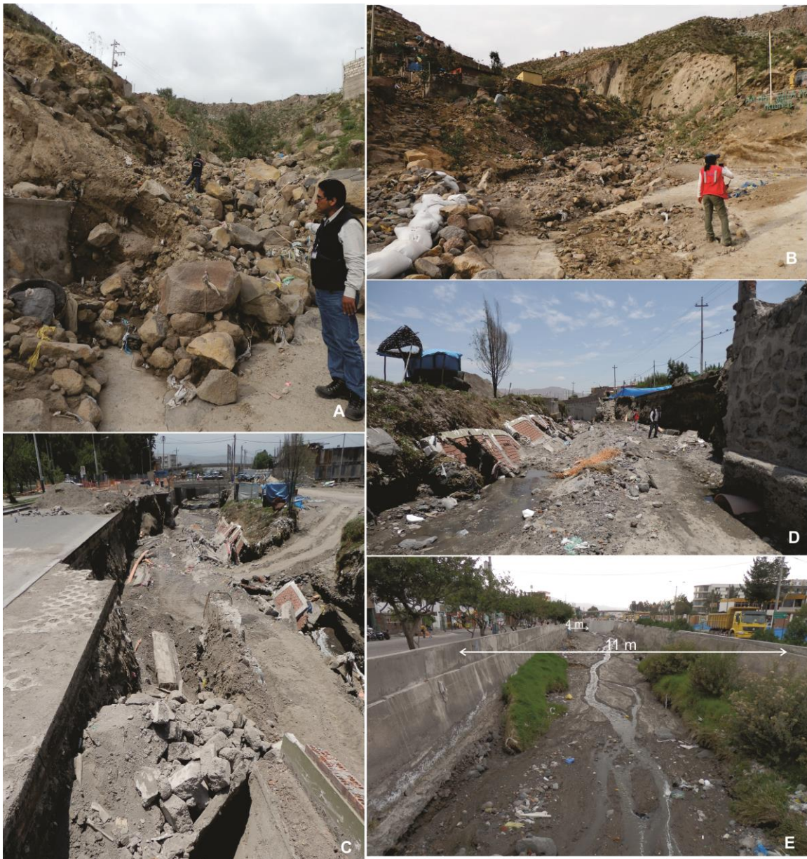
Foto 71. A y B) Las cabeceras de las torrenteras se encuentran afectadas por deslizamientos y flujos. Además, los cauces se encuentran colmatados de material, sector La Rinconada, distrito Mariano Melgar. C y D) Presenta erosión de la vía asfaltada en la Av. Venezuela, debido al socavamiento de los cimientos de muros de sillar del mercado que generaron el colapso de los mismos, en el mercado Mariscal Castilla. E) Av. Los Incas y Agricultura (altura de la Gerencia Regional de Salud). Estrechamiento del cauce por obras del bypass de 13 a 4 m de ancho con muros de contención de 4, 5 m de alto.
