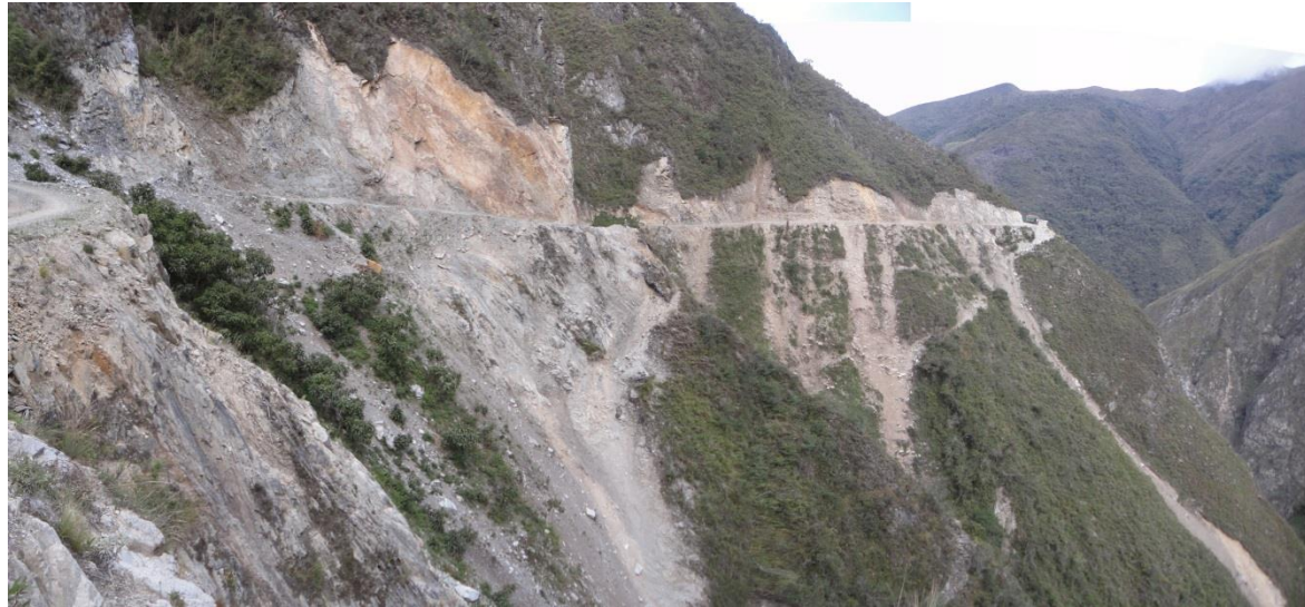
Foto 7.4. Derrumbes en el talud superior de la carretera Anturqui – Huanchuiro (San Pedro de Cajas, Tarma).
