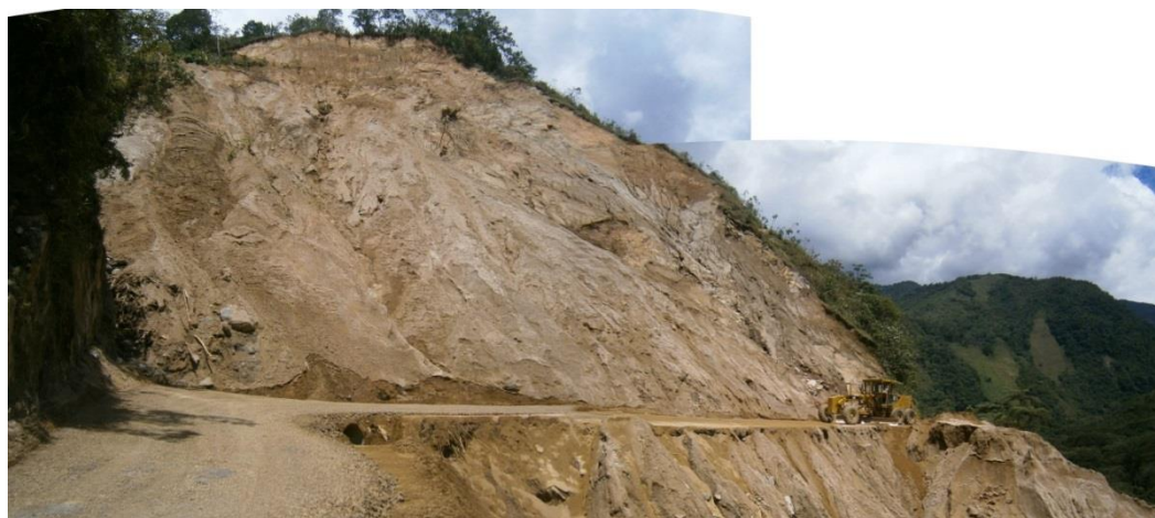
Foto 7.26. Carretera Comas-Satipo que por sectores la plataforma ha sido erosionada por el río Yungorplaya.
