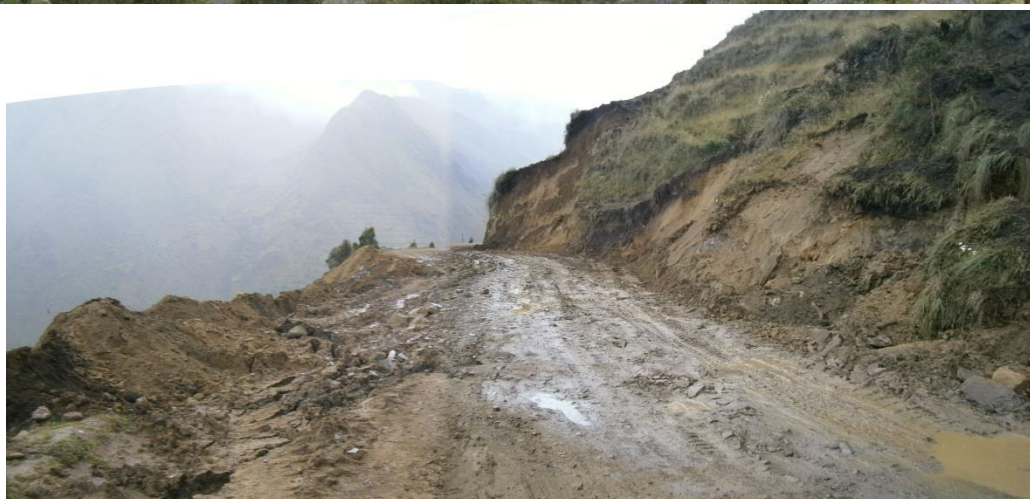
Foto 7.21. Vista panorámica del sector Runatullo asentado sobre un piedemonte coluvio-deluvial del cerro Alfonsito, algunas viviendas del poblado Runatullo se encuentran muy cerca de la zona de arranque de derrumbes cuyo avance es retrogresivo (arriba). En la parte inferior tramo de la carretera Comas-Runatullo afectado por derrumbes y huaicos (abajo)
