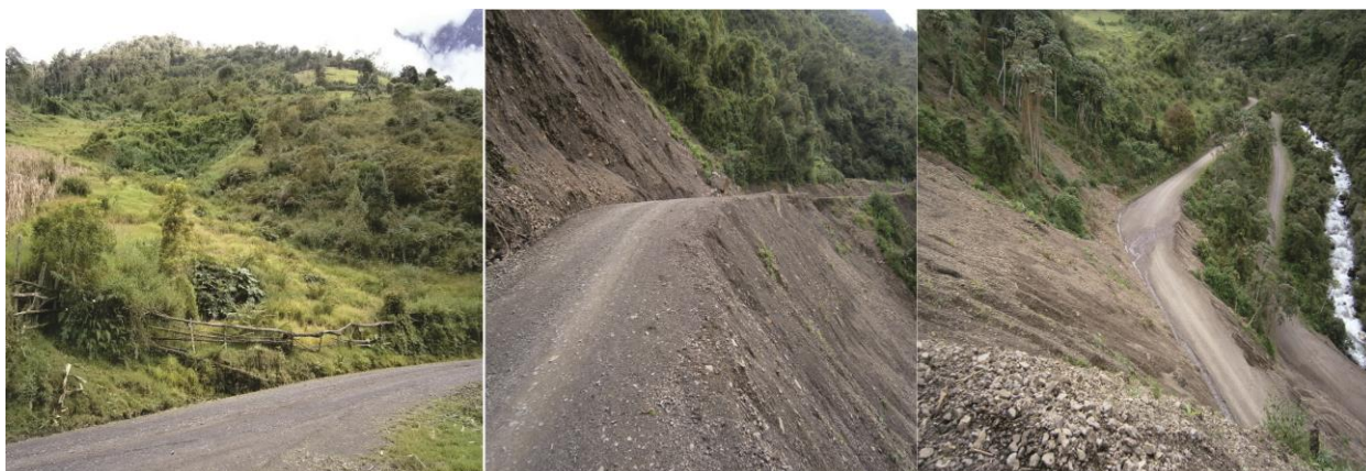
Foto 7.25. Deslizamiento activo con presencia de asentamientos y derrumbes en la carretera Comas – Satipo, en el km 152+950.
