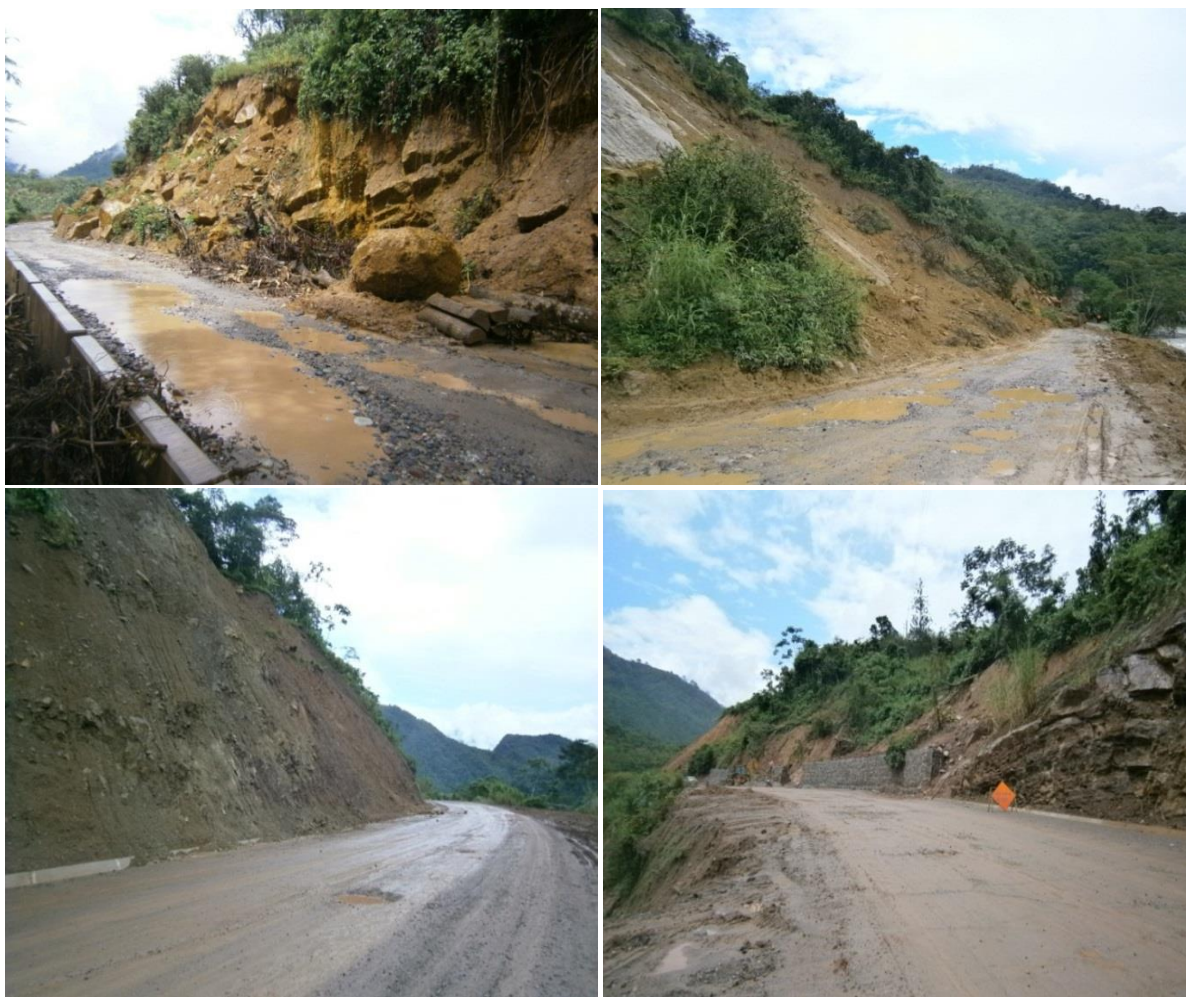
Foto 7.8. Vista de diferentes tramos de la carretera La Merced – Paucartambo, sector Puente Capelo donde se observa el suelo saturado que genera flujos y derrumbes, obstaculizando el tránsito.
