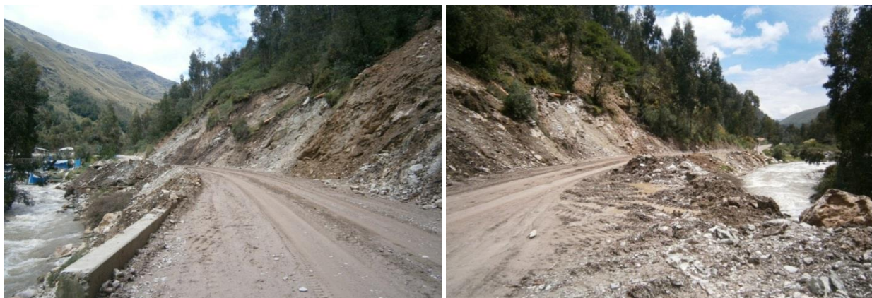
Foto 7.29. Derrumbes en el talud superior de la carretera a Huancayo, tramo km 4+800 al km 7+100 de la carretera, ambas márgenes del río Shullcas.
