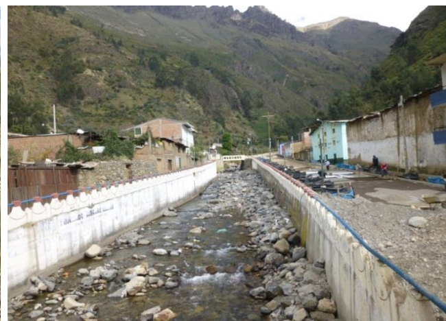
Foto 26. Río Yauyos con presencia de bloques y cantos en cauce del río. Aguas abajo del poblado de Yauyos (der.), río encausado cruza por el poblado de Yauyos, puede afectar puente (izq.).
