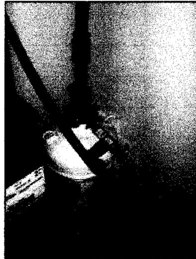
Como se puede observar el sistema de extinción de incendios está rodeado de cajas y cableado inutilizado, lo cual dificulta su acceso para manipulación y/o mantenimiento preventivo. Adicionalmente uno de los sistemas de seguridad se encuentra conectado a una toma de energía comercial, así como se evidencia la existencia de un cableado trenzado que rodea los gabinetes.
