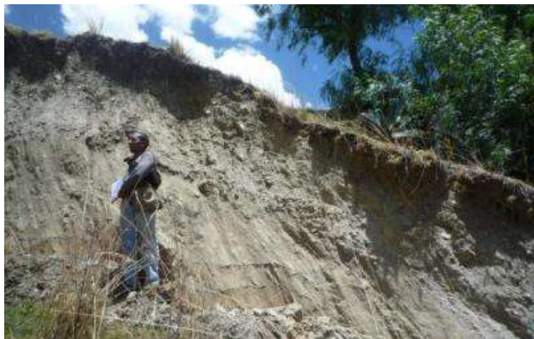
Foto 8. Zona crítica N°7 asentamiento de terreno en la margen derecha de la quebrada Checcasa, el desnivel observado es de 2.2 m.
