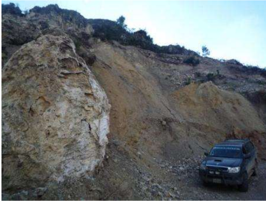
Foto 2. Derrumbe del cerro Chantacca (distrito de Tapairihua, provincia de Aymaraes) donde el substrato está muy meteorizado y fracturado y predominan los depósitos de material suelto.
