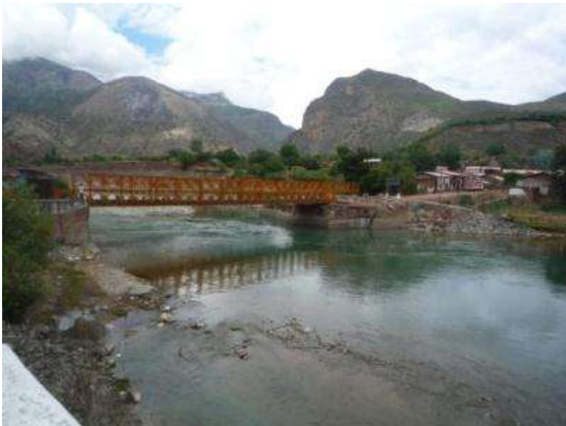
Foto 25b. Dos vistas de los alrededores del puente Pampatama en el acceso a Tintay, a la altura del km 62 de la vía afirmada Chalhuanca-Abancay. El sector altamente susceptible a erosión fluvial e inundación.
