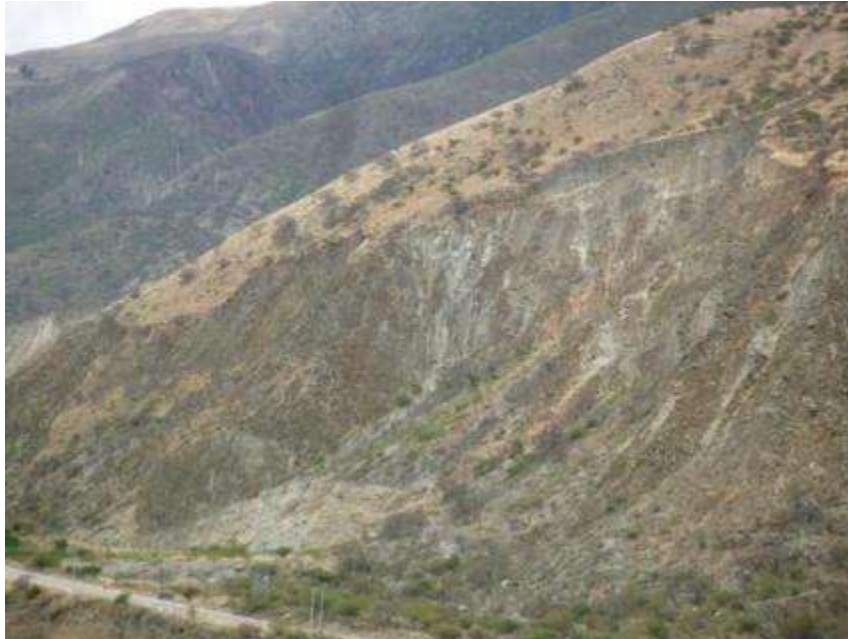
Foto 6. Deslizamiento en la margen izquierda del río Pachachaca, a la altura del cerro Churuccasa que afecta a la vía Chalhuanca-Abancay
