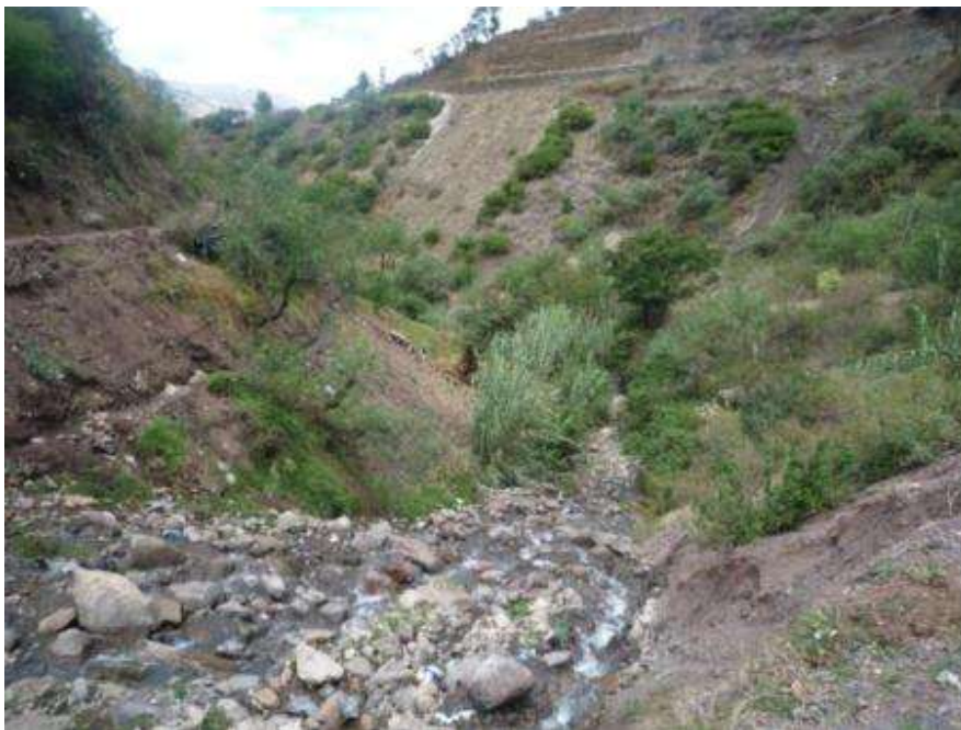
Foto 10. Flujo de detritos_Qda. Ñanpuquio-Ñacchero) (distrito de Pichirhua, provincia de Abancay) afectando a la autopista de acceso a Abancay.
