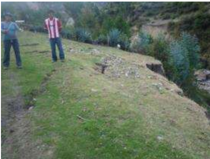
Foto 9c. Nueva escarpa retrogresiva en la parte alta del deslizamiento de Juta (distrito de Lucre)
