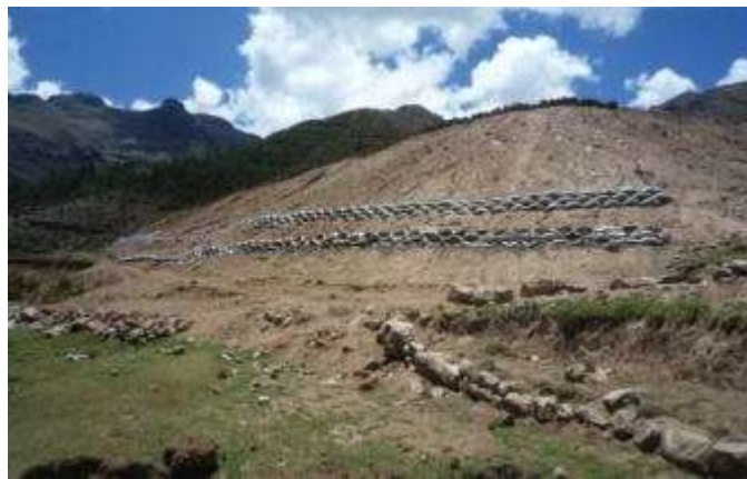
Fotos 7a y 7b. Deslizamiento de Tiaparo.
