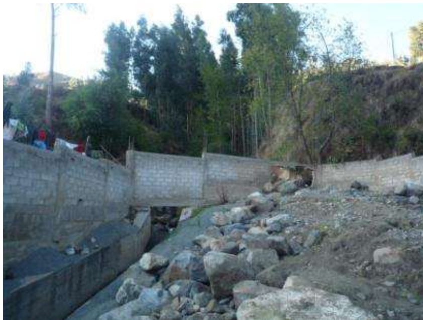
Fotos 14 a y b. Flujo de la quebrada Santa Lucía. (a) material heterogéneo con bloques de hasta 1.5 m de longitud. (b) Obsérvese que el material del flujo rompió paredes del canal del barrio San Martín (distrito de Tambobamba y provincia de Cotabambas).
