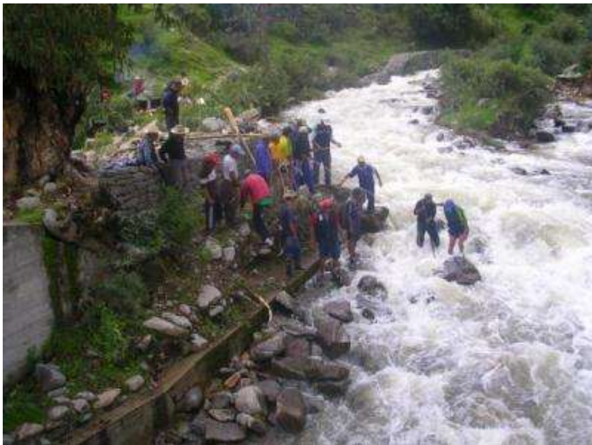
Foto 23 Pobladores de Totora-Oropesa tratando de reforzar defensas ribereñas en la margen derecha del río Oropesa (Foto por cortesía del GORE Apurímac, enero del 2004)
