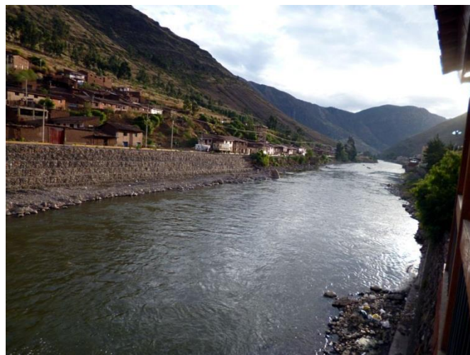
Foto 46: Tramo encauzado del río Vilcanota con gaviones.
