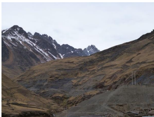
Foto 55: Derrumbes y deslizamientos en talud superior e inferior de carretera, compromete secuencia de pizarras negras, produce pérdida de plataforma de carretera, km 104+900 de la Interoceánica.
