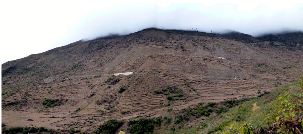
Foto 48: Dos desarrollos de la carretera Interoceánica cerca de la localidad de Marcapata, se presentan taludes inestables por trabajos de ampliación de carretera.
