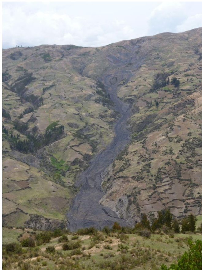
Foto 104: Derrumbe-flujo de detritos cerca al poblado de Jaquira, zona de arranque inicia en el talud inferior de carretera.
