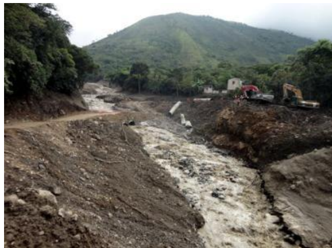
Foto 29: Quebrada Yuracmayo, vista tomada el 14 de febrero, se observa la magnitud del evento, socavó y erosiona su cauce.
