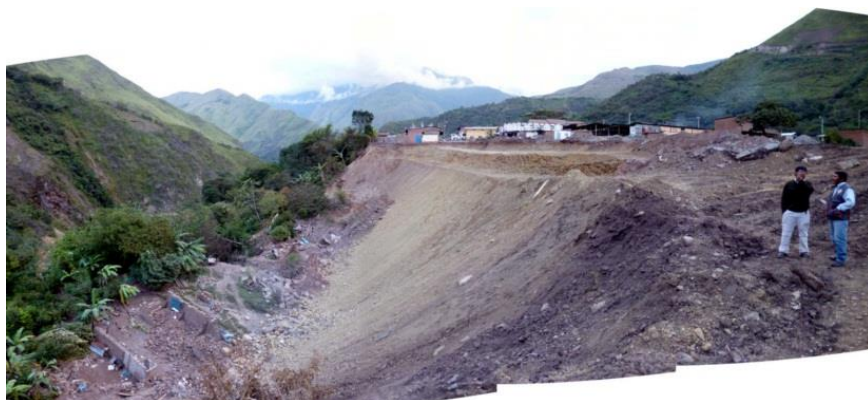
Foto 20: Superficie de ruptura cóncava del deslizamiento de Ocobamba, que produjo la destrucción de 30 viviendas en el poblado de Ocobamba.
