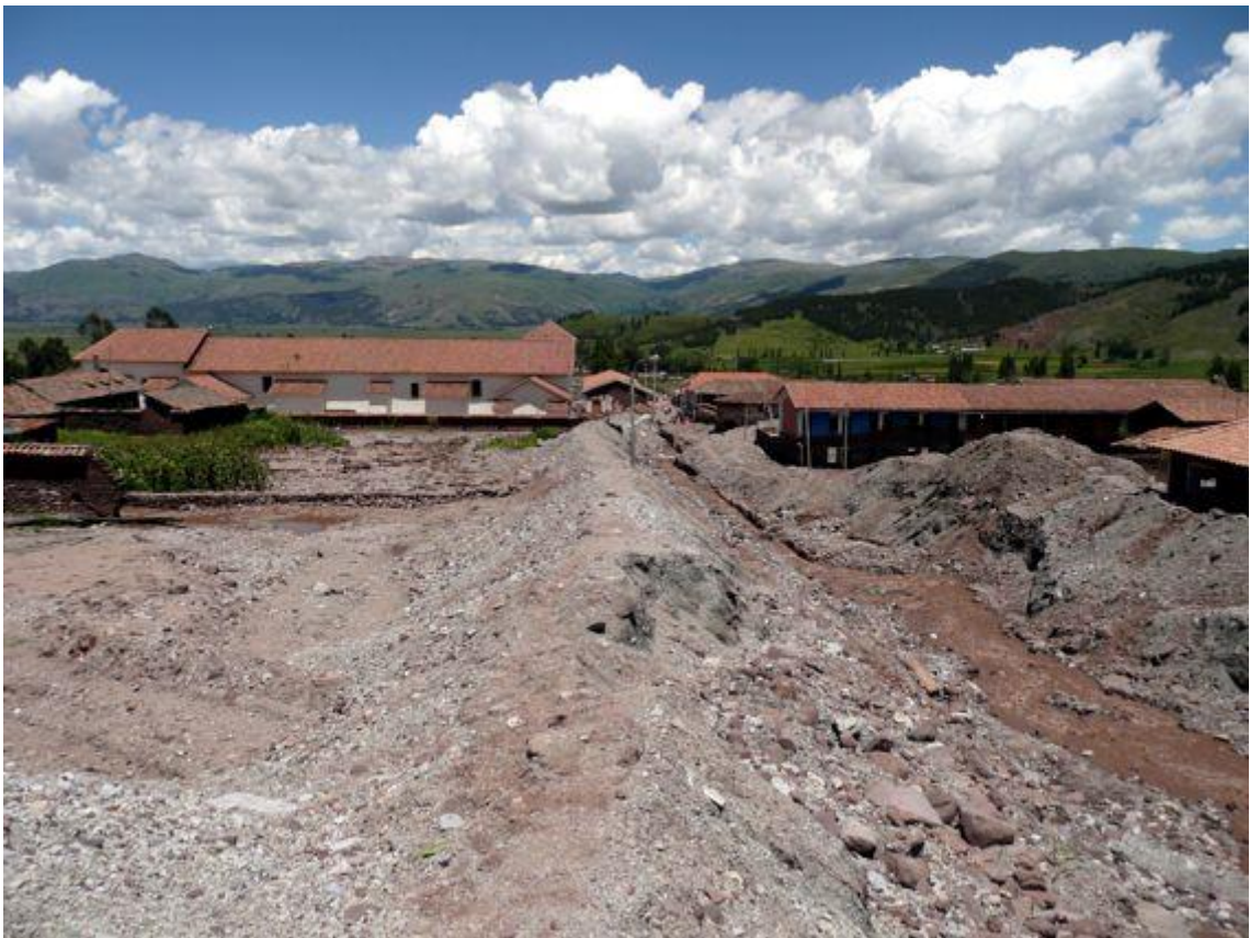
Foto 79: Cauce colmatado de la quebrada Qenqo, el material transportado superó la capacidad de carga del canal produciéndose desbordes y la formación de albardones. El flujo de detritos afectó viviendas y calles de Zurite.
