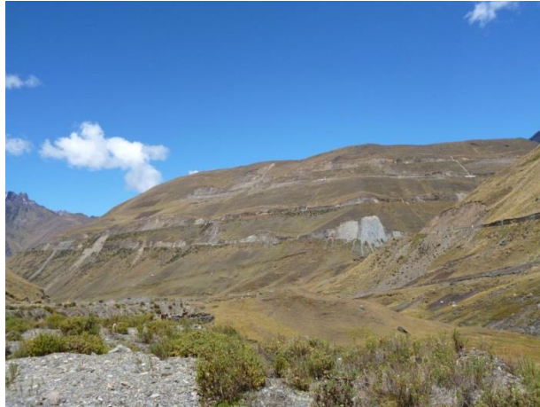
Foto 80: Desarrollo hacia el Abra Malaga, presenta problemas de derrumbes y deslizamientos en sus taludes superiores por obras de ampliación de la plataforma.
