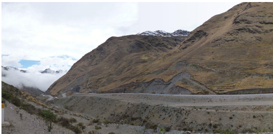
Foto 54: Talud superior inestable por trabajos de ampliación de carretera interoceánica, compromete substrato de pizarras, filitas y depósitos coluviales, a la altura del km 109+900.
