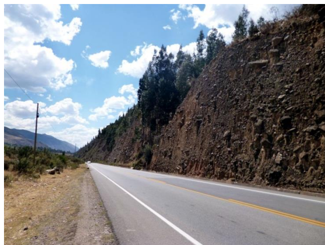
Foto 70: Talud superior de carretera subvertical entre el km 1048+800 al km 1049+100, se producen derrumbes y caídas de clastos.
