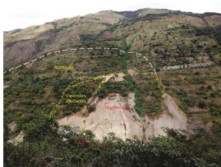
Foto 16: Vista del deslizamiento de Acospata.
