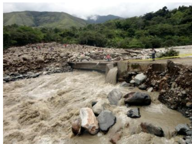
Foto 11: Puente que cruza el río Lúcura cubierto por el flujo de detritos de la quebrada Calquiña en Huyro.
