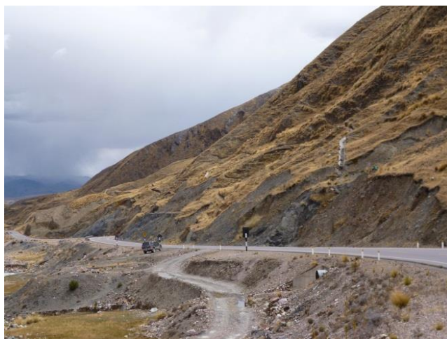
Foto 58: Taludes superiores inestables de la carretera Interoceánica en el sector de Cotaña, se han colocado cunetas de coronación en la zona.
