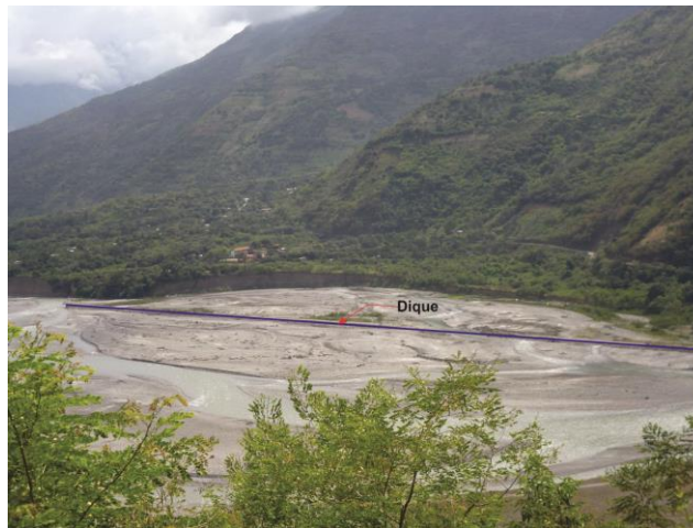
Foto 28: Sector de Mandor, afectado por erosión fluvial.
