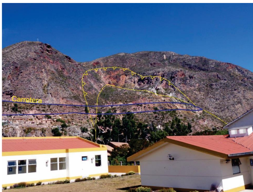
Foto 93: Deslizamiento que produce el asentamiento de la carretera que permite el acceso a Urubamba.
