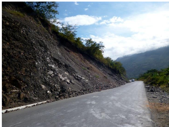
Foto 26: Derrumbes en el talud superior de la carretera km136+900, material caído obstruye la cuneta.
