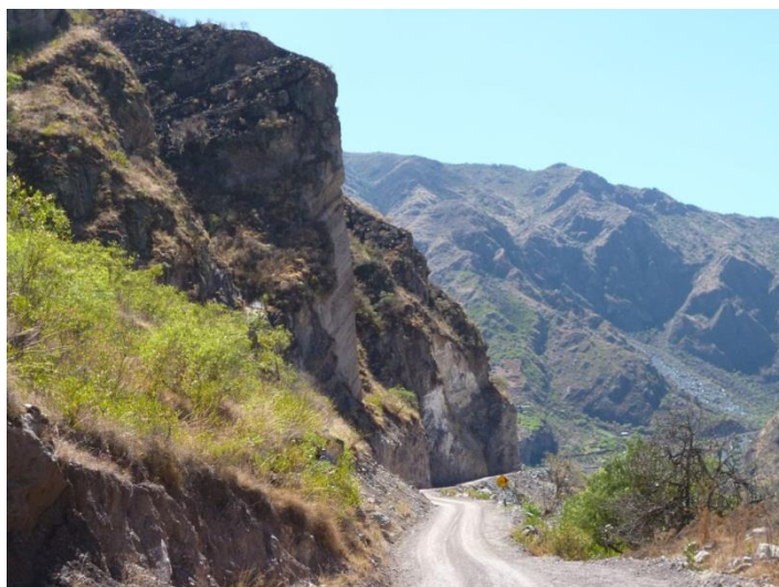
Foto 108: Talud de corte vertical de casi 40 m de altura, muy inestable, desde donde se produce la caída de bloques de roca y suelo.
