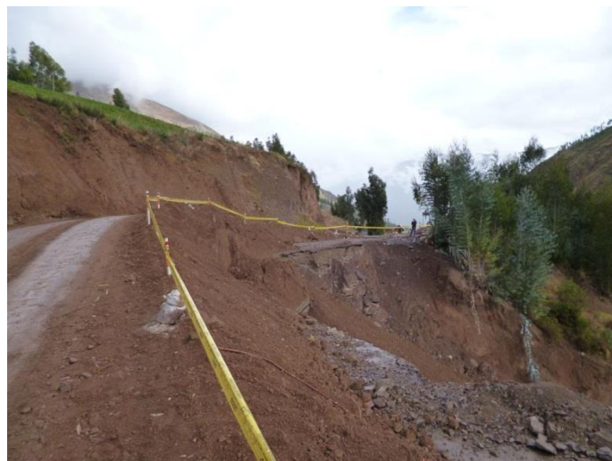
Foto 37: Deslizamiento que corto toda la plataforma de carretera en el km 3+630 de la carretera Calca-Yanatile, sustrato de areniscas, limolitas roja e ignimbritas.
