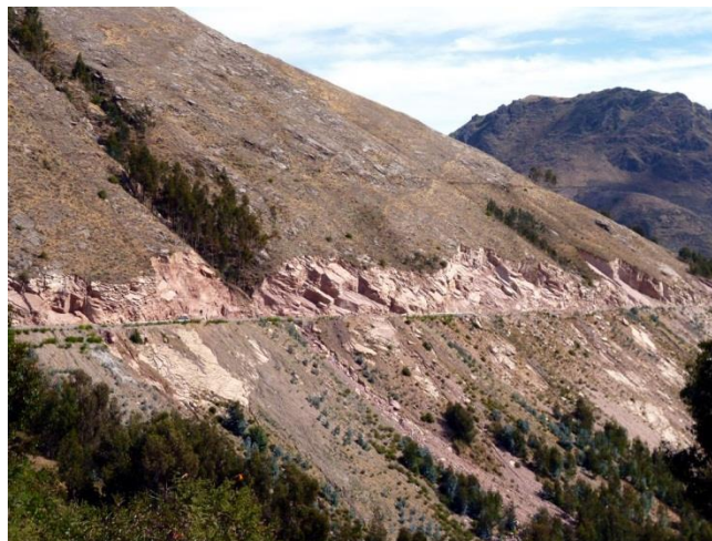
Foto 101: Secuencia de la Formación Huancané que se inclina a favor de la pendiente de la ladera, caída de bloques por falla planar entre el km 12+100 al 16+100 de la carretera a Huancarane.
