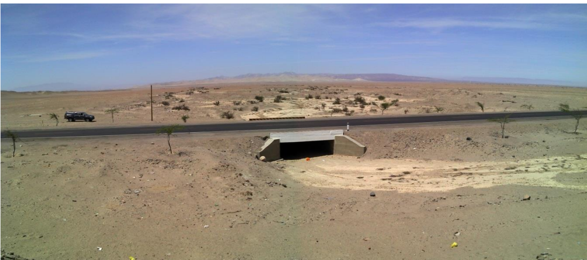
Foto 14: Quebrada que se activa excepcionalmente a la altura del km 377 de la Carretera Panamericana Sur.
