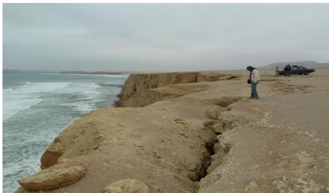
Foto 7: Asentamientos y agrietamientos en acantilado de Playa Las Salinas, extremo Sur de Playa Yumaque.
