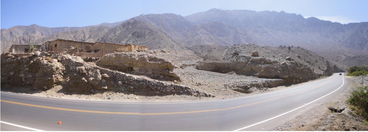
Foto 10: Viviendas del sector de Lauta asentadas en abanico de huayco antiguo, carretera cruza la quebrada que se activa excepcionalmente.
