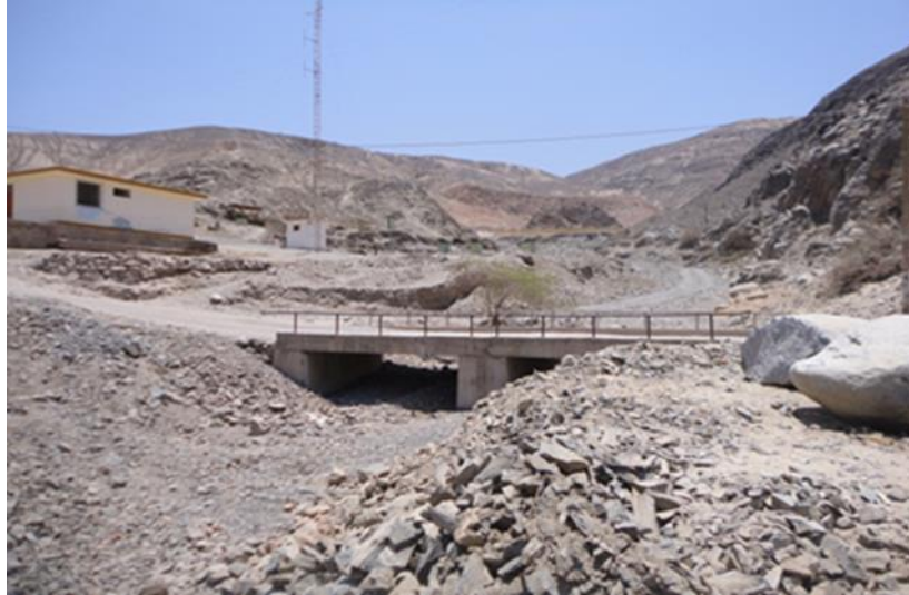
Foto 4: Sector de Saramarca, viviendas asentadas muy cerca de quebrada que se activa excepcionalmente y acarrea flujos.
