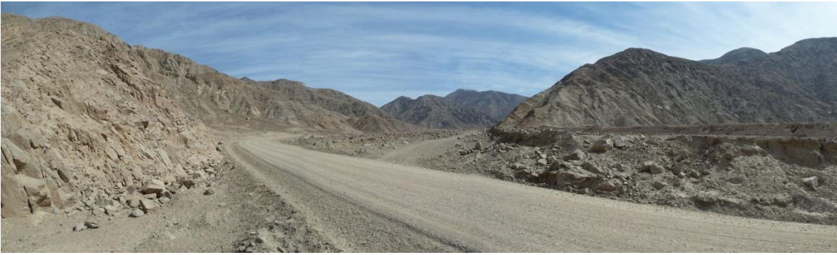
Foto 1: Tramo Culebrillas trazado en cauce de quebrada que se activa excepcionalmente, puede ser afectada por flujos de detritos.
