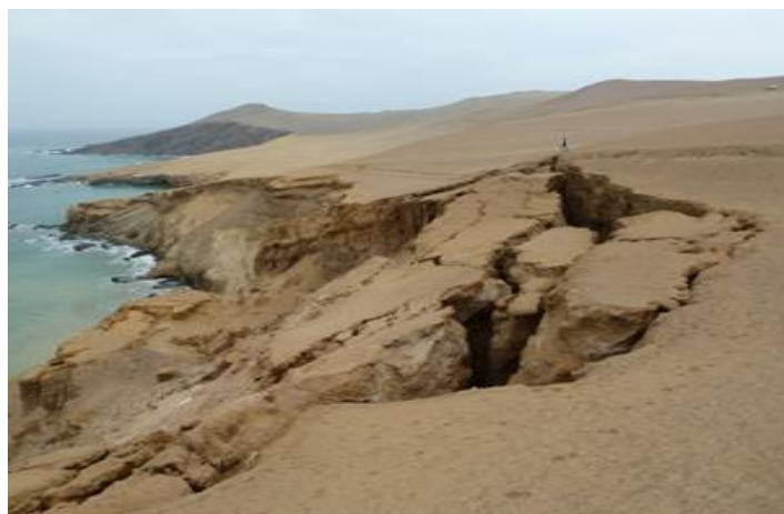
Foto 9: Acantilado con fracturas y desprendimientos a favor de la pendiente en el sector de la mina- Bahía de Paracas.
