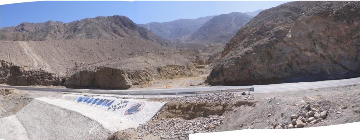
Foto 11. Quebrada Chivato loco, se activa excepcionalmente y acarrea flujos de detritos, puede cortar el paso por la carretera Libertadores Wari.
