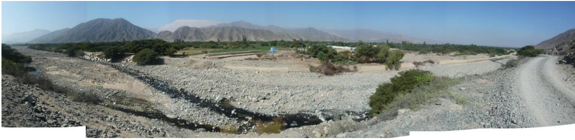
Foto 15: Sector de Orcona en la margen izquierda del río Aja, se han colocado muros de concreto y arrimado de material de río para controlar los procesos erosivos y la inundación fluvial.
