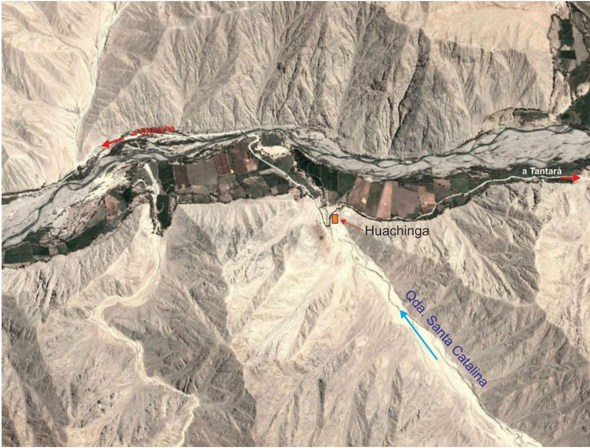
Figura 4: Imagen Google Earth, donde se puede observar la carretera a Tantar\'a, el puente y el poblado de Huachinga que se asienta en la margen derecha de la quebrada Santa Catalina.
