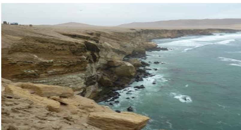
Foto 8: Sector Punta de Arquillo, desde donde se produjo caída de rocas que afectaron zona de descanso de lobos marinos.
