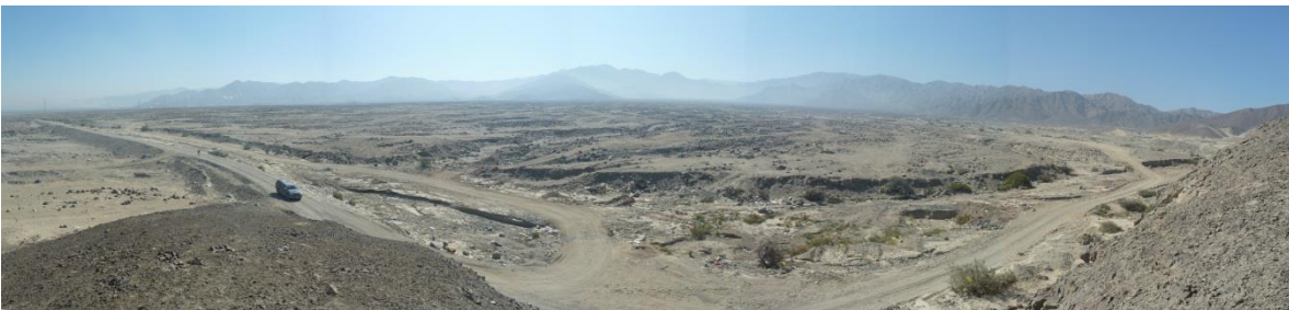
Foto 13: Quebrada Cansas, se activa excepcionalmente y acarrea flujos de detritos, se ha construido un dique transversal al cauce de la quebrada para encausar sus aguas.
