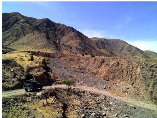
Foto 6: Qda. Gramadal, falta construir un badén o pontón, carretera a Tibillo.
