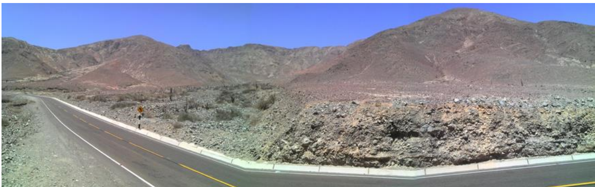
Foto 17: Depósitos en forma de abanicos, acumulados por husyos excepcionales, cauce de torrentera seca a la altura del Km 16+380 Carretera Nazca-Puquio.
