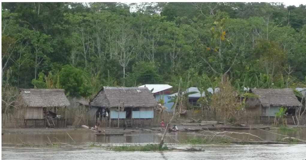
Foto N° 27: Tiber Playa II Zona, el área es susceptible a erosión fluvial e inundaciones. Las viviendas para protegerse de la inundación están construidas sobre columnas de madera.
