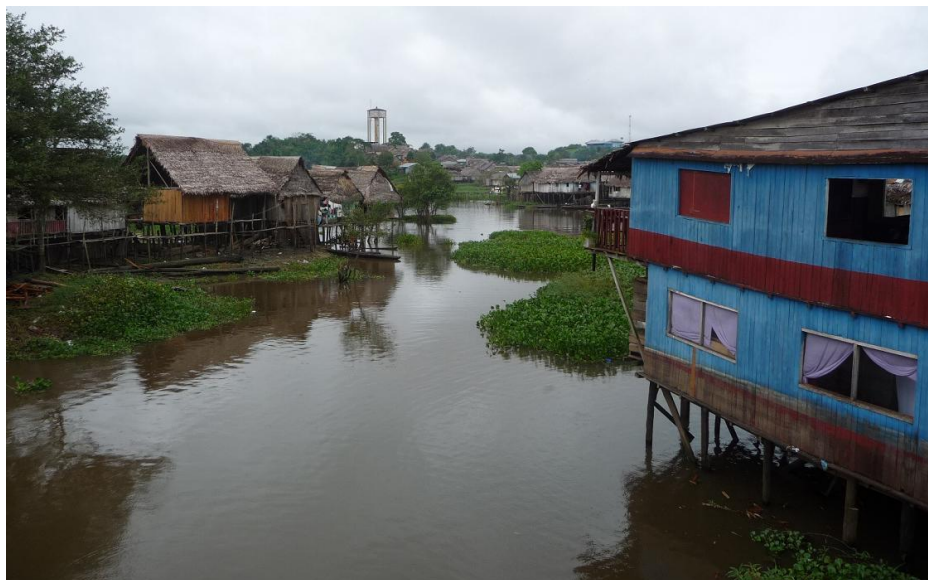
Foto N° 23: Quebrada Guarnición, vista aguas arriba. Las viviendas para protegerse de la inundación están construidas sobre columnas de madera.
