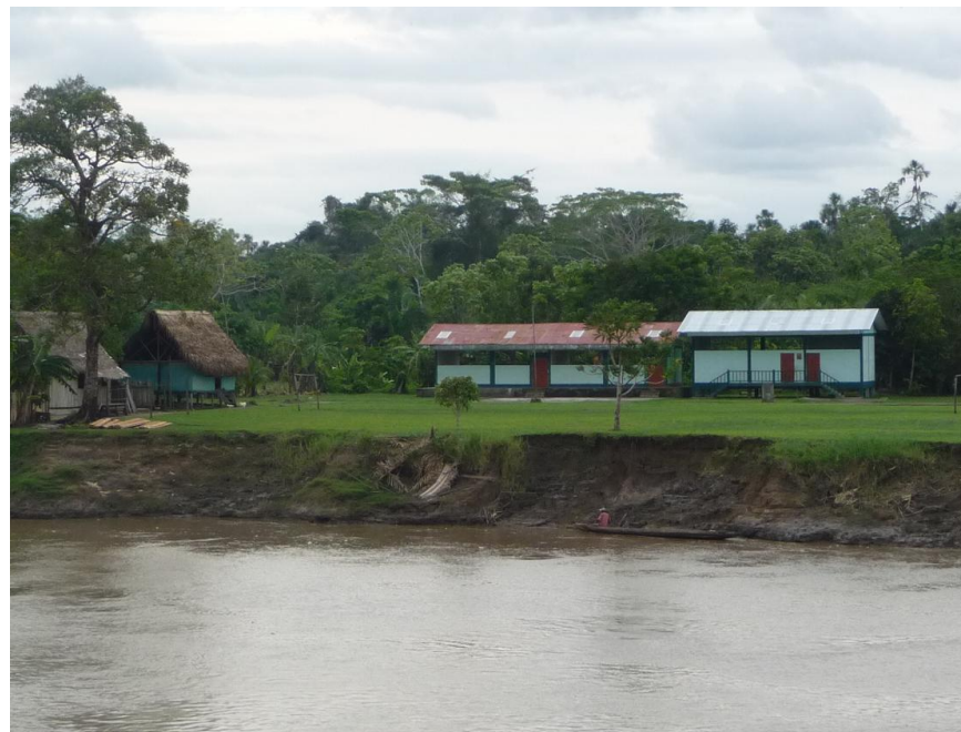
Foto N° 37: Nueva Unión, área susceptible a inundaciones.
