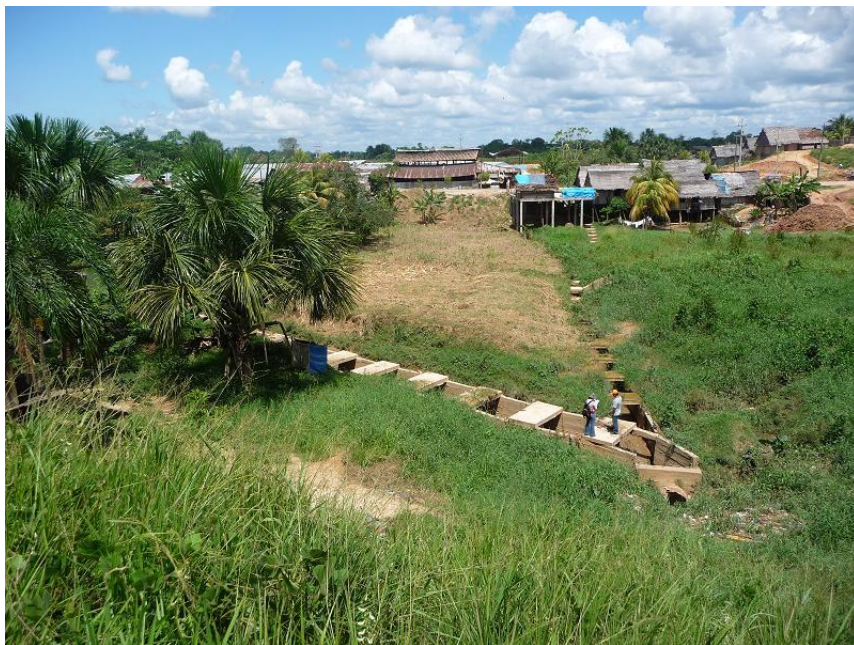
Foto 30: Qda. Alta - AA. HH. Los Maderos. Vista de los canales de drenaje.
