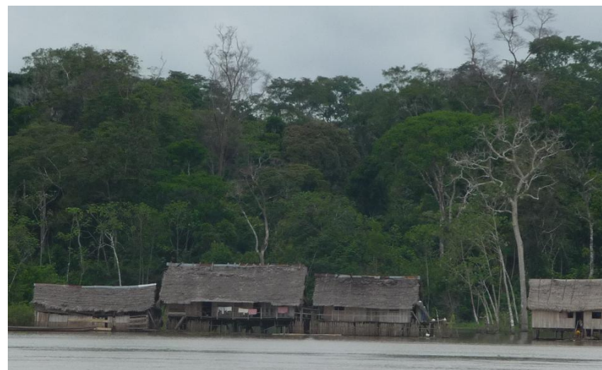
Foto N° 28: Puerto Sol - 28 de Julio, susceptible a inundaciones y erosión fluvial. Las viviendas para protegerse de la inundación están construidas sobre columnas de madera.
