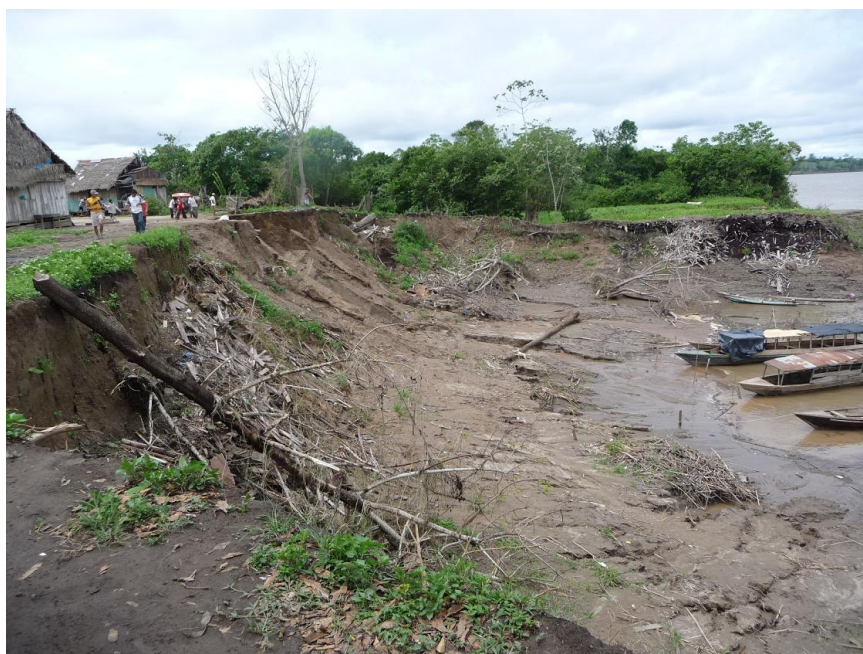
Foto N° 1: Sector Roaboya, vista de erosión fluvial que avanza al caserío.
