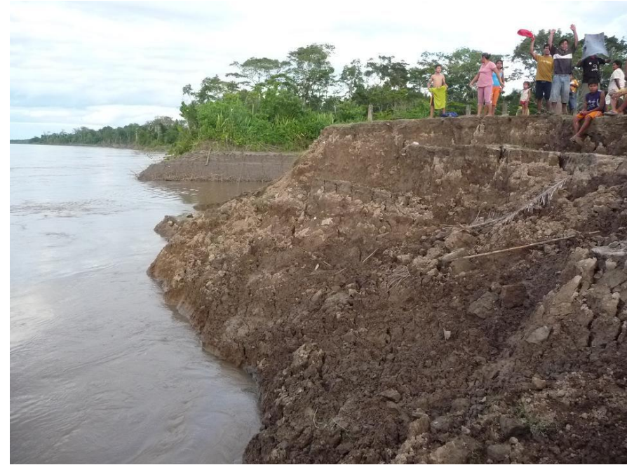
Foto N° 12: Boca de Catalina, margen afecta por erosión fluvial.
