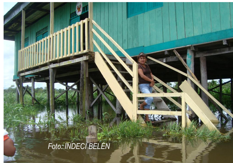
Foto 48: San José, sector afectado por la inundación.
