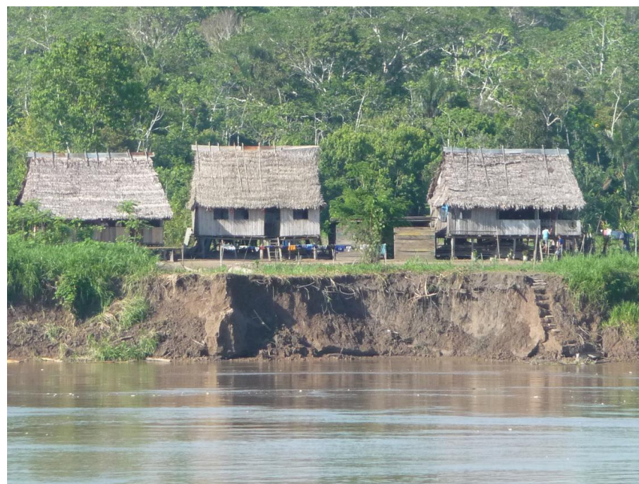
Foto N° 41: Nuevo Miraflores – Palizada. Las viviendas para protegerse de la inundación están construidas sobre columnas de madera.
