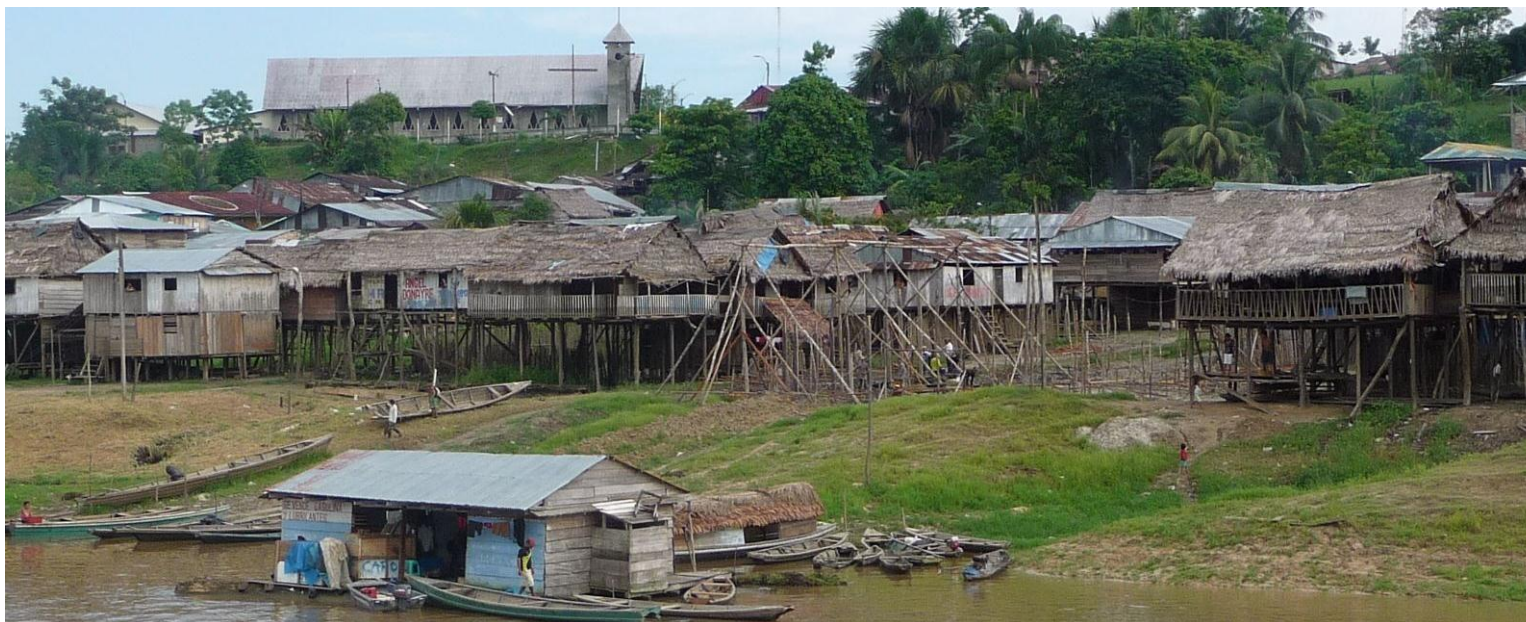
Foto N° 55: Embarcadero Pebas. Sector susceptible a inundaciones. Las viviendas para protegerse de la inundación están construidas sobre columnas de madera.
