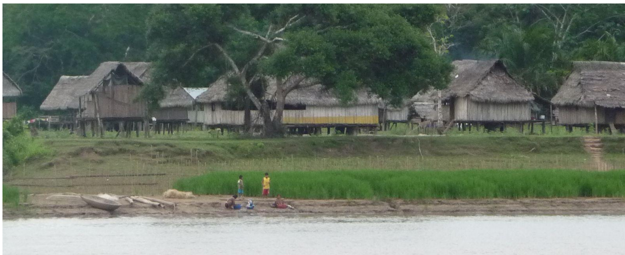
Foto N° 31: Barrio La Boca. Las viviendas para protegerse de la inundación están construidas sobre columnas de madera.
