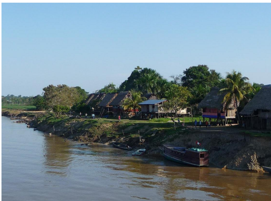
Foto N° 40: Puerto Orlando- Miraflores. Las viviendas para protegerse de la inundación están construidas sobre columnas de madera.
