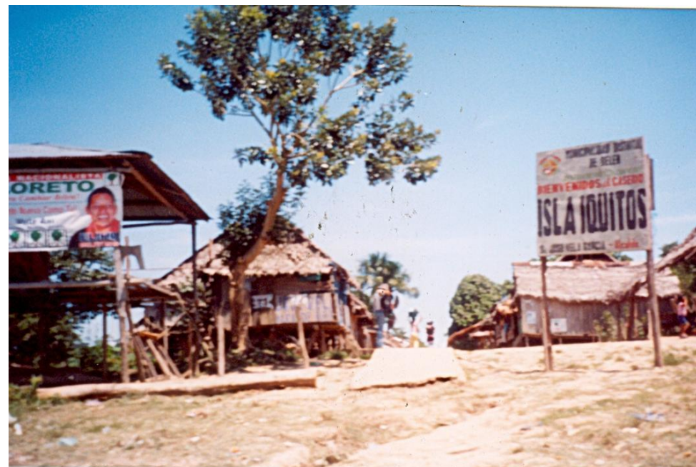
Foto 50 b): Isla Iquitos. Foto tomado en noviembre 2009. Algunas viviendas para protegerse de la inundación están construidas sobre columnas de madera.
