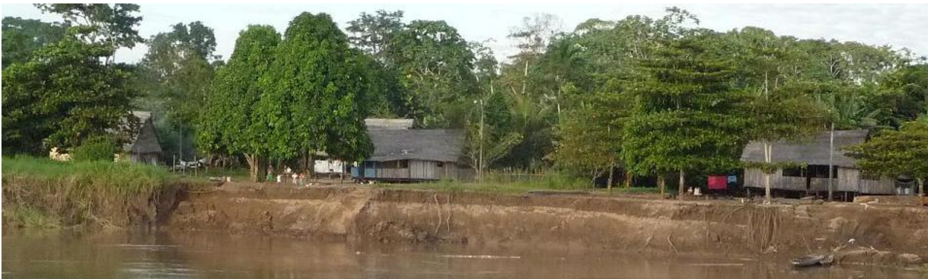
Foto N° 10: Dos Hermanos, sector susceptible a inundaciones y erosión fluvial. Las viviendas para protegerse de la inundación están construidas sobre columnas de madera.
