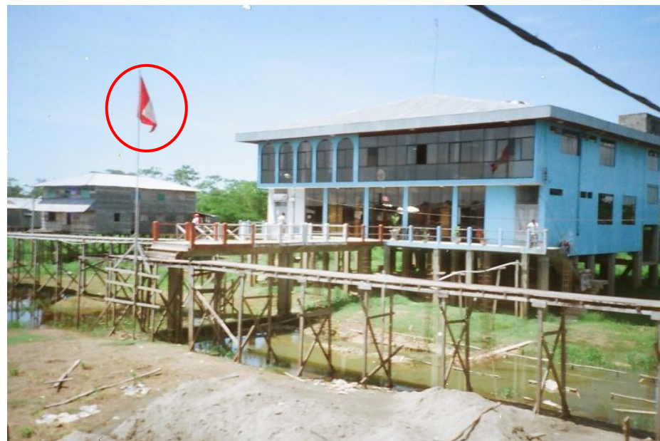
Foto N° 57 b): Local Municipal de Yavarí (Islandia), se observa la construcción de vías de acceso en base a concreto y madera. Foto tomado en octubre 2009.
