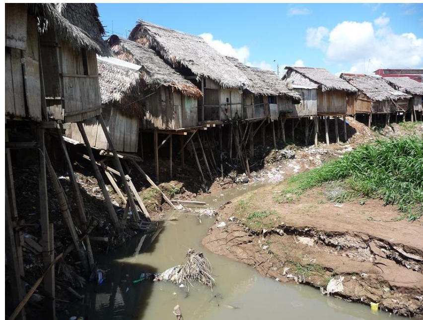
Foto N° 31: Barrio La Boca. Las viviendas para protegerse de la inundación están construidas sobre columnas de madera.
