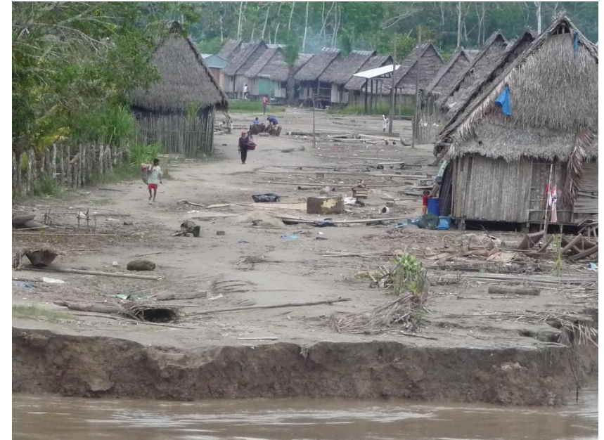
Foto N° 19: Bolívar, el área es susceptible a erosión fluvial e inundaciones.
