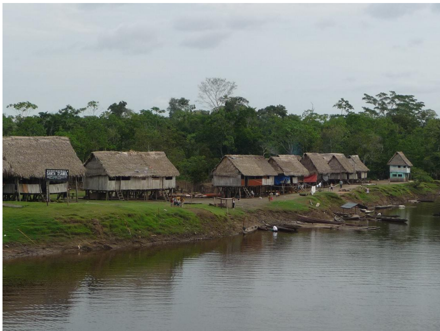
Foto N° 36: Boca Nucuray-Santa Isabel, área susceptible a inundaciones. Las viviendas están construidas sobre columnas de madera.
