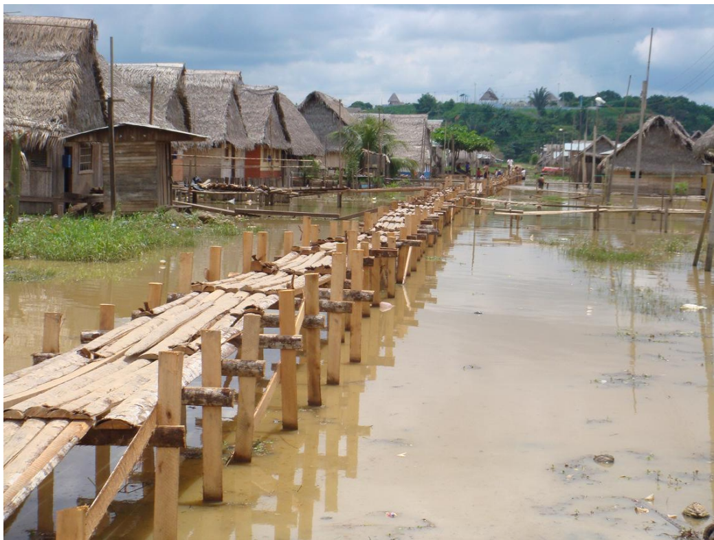
Foto N° 5: Barrio Manuel E. Rojas B, afectado por Inundación fluvial. Se observa la construcción de vías de acceso a base de madera.
