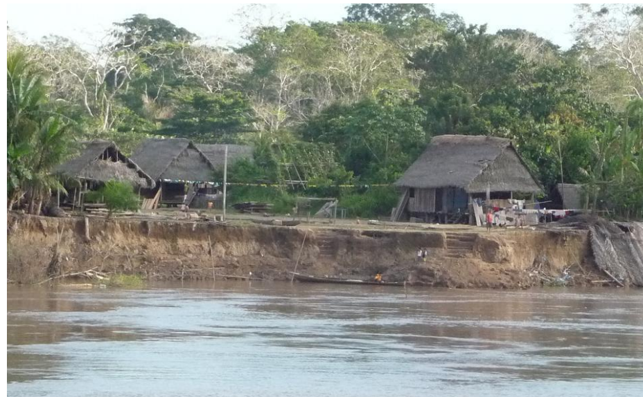
Foto N° 9: Huamantullo, sector susceptible a inundaciones y erosión fluvial.
