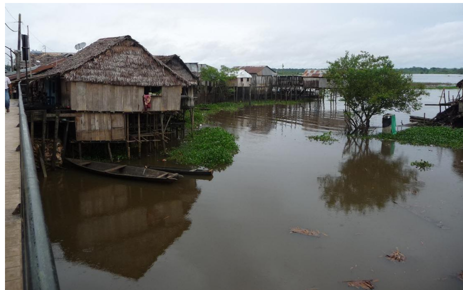
Foto N° 24: Quebrada Guarnición, vista aguas abajo. Las viviendas para protegerse de la inundación están construidas sobre columnas de madera.
