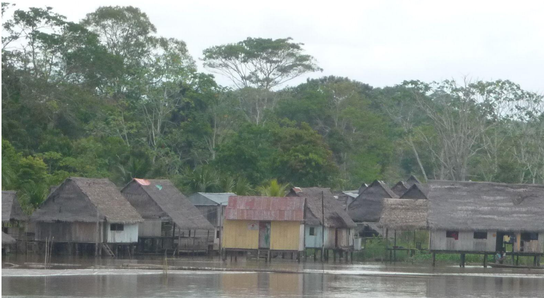
Foto 29: Libertad, área susceptible a inundación y erosión fluvial. Las viviendas para protegerse de la inundación están construidas sobre columnas de madera.
