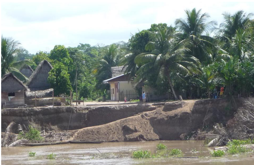
Foto N° 8: Ipuano, sector afectado por la erosión fluvial.
