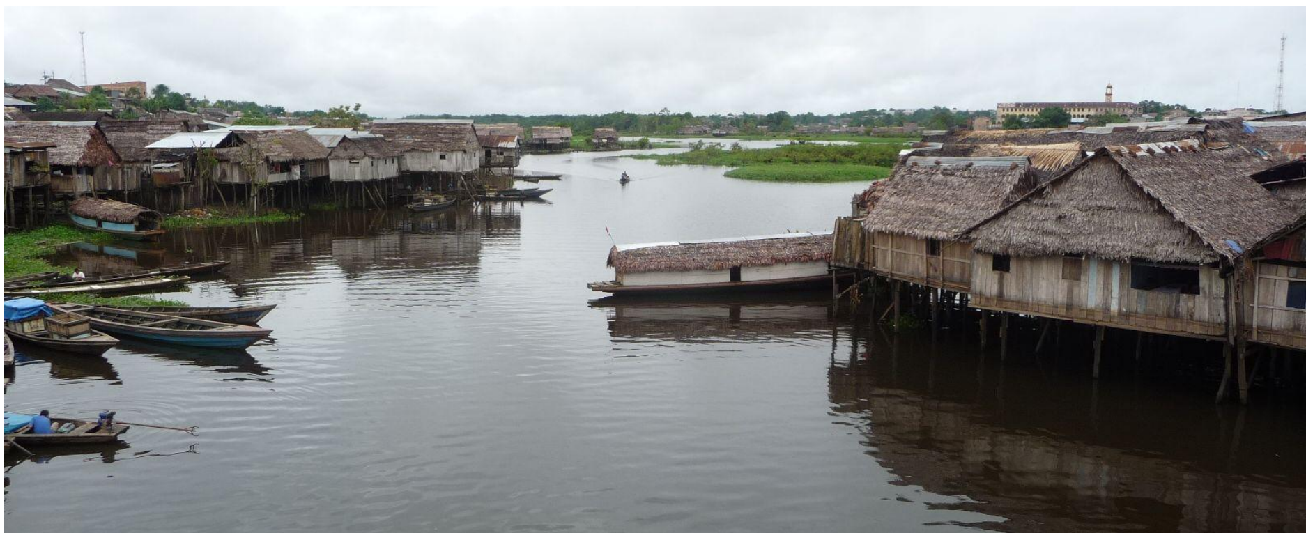
Foto N° 22: Quebrada Camaná, viviendas ubicadas en ambas márgenes es afectada por inundaciones. Las viviendas para protegerse de la inundación están construidas sobre columnas de madera.
