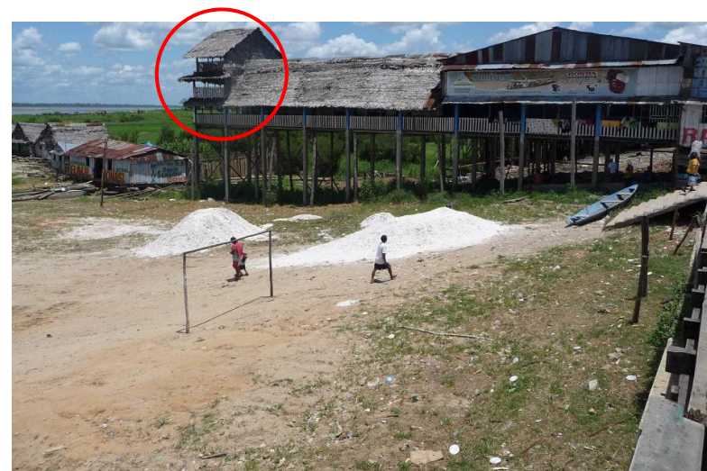
Foto N° 54 b): Bellavista Nanay. Foto tomado en octubre 2009. Las viviendas para protegerse de la inundación están construidas sobre columnas de madera.
