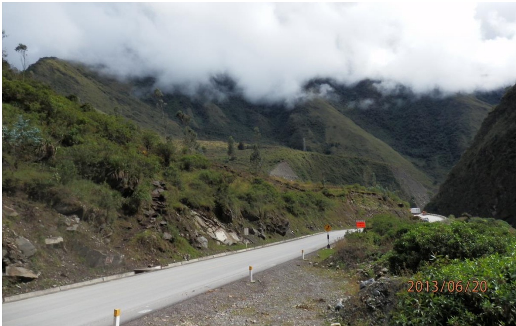
Foto 5. Sector Moyopampa, susceptible a derrumbes, erosión fluvial y flujo de detritos. Afecta tramo de carretera Ollachea – San Gabán
