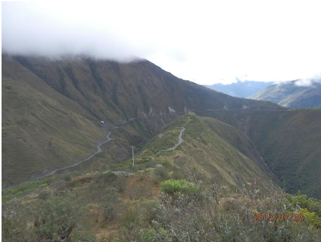
Foto 20. Tramo de carretera Miraflores – Quiaca Km 6+400. Zona susceptible a deslizamientos, derrumbes y flujo de detritos, afecta carretera afirmada
