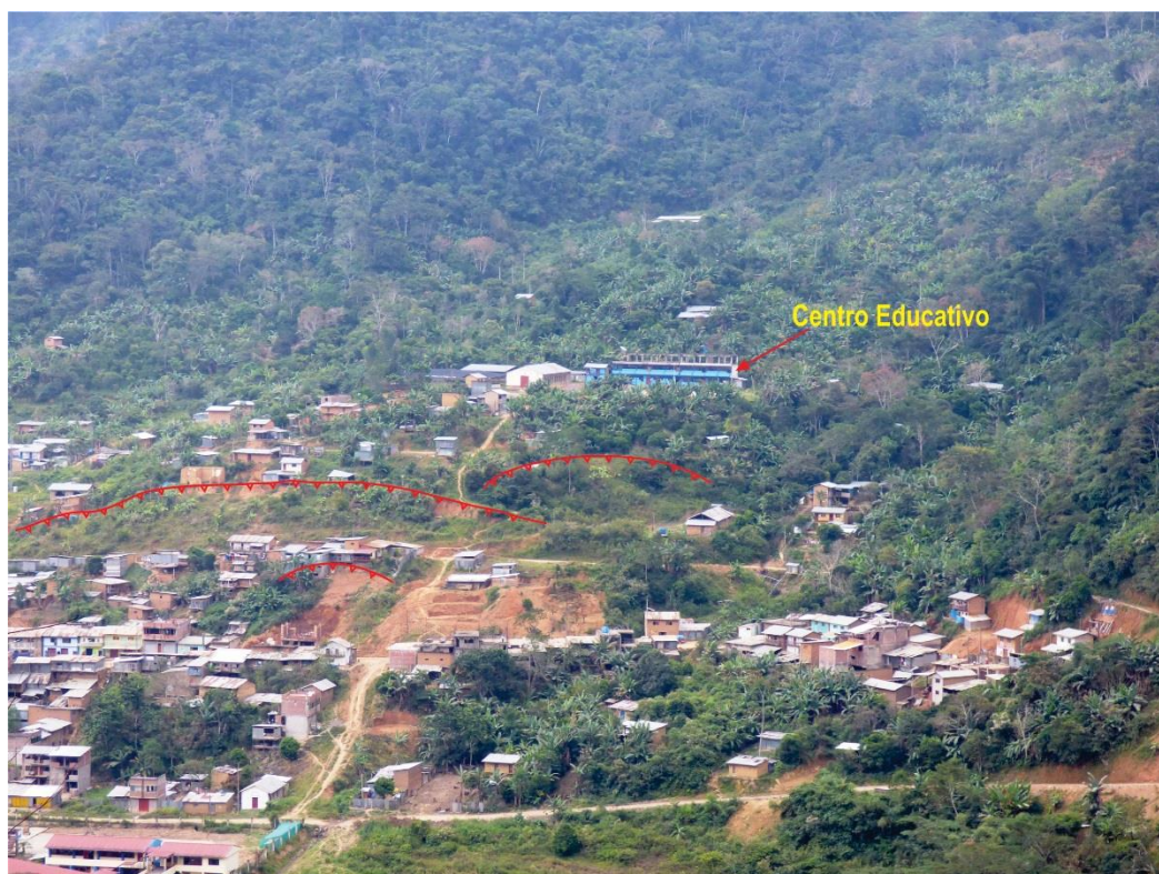
Foto 26. Vista del poblado de Putina Punco. Se observa deslizamiento confinado. Afecto viviendas e infraestructura
