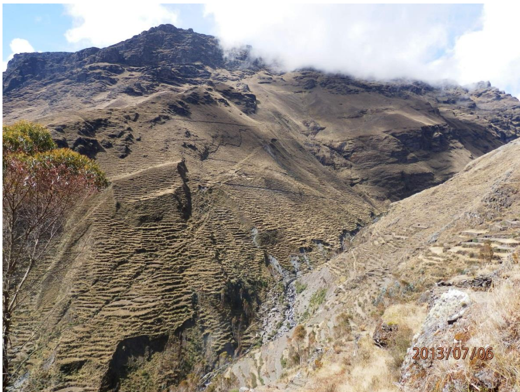
Foto 24. Vista panorámica del sector Jilari, en el distrito de Cuyo Cuyo. Zona susceptible a derrumbe, deslizamiento, huaico y erosión. Afectaría viviendas que se encuentra aguas abajo de la quebrada Jilari.
