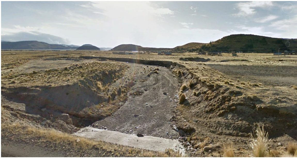
Foto 10. Vista del sector Sacsani, susceptible a huaycos e inundación. Generado por la presencia de lluvias intensas
