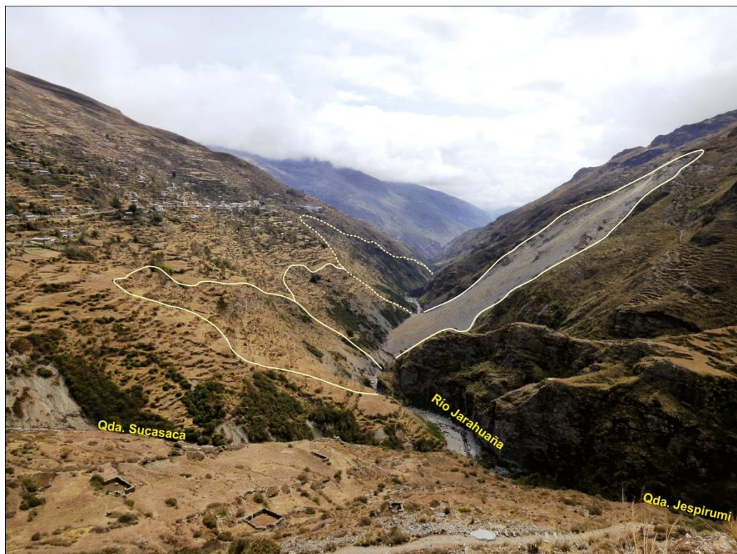
Foto 21. Sector Jaruhuaña, susceptible a derrumbes, deslizamientos y erosión de ladera. Se puede observar en línea blanca derrumbe reciente 2014, en línea amarillas eventos antiguos
