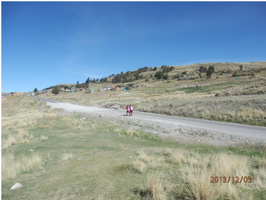
Foto 12. Vista del sector Cruzpata es susceptible a reptación de suelos y hundimiento, afecta tramo de carretera Juli - Pomata, km 1+500
