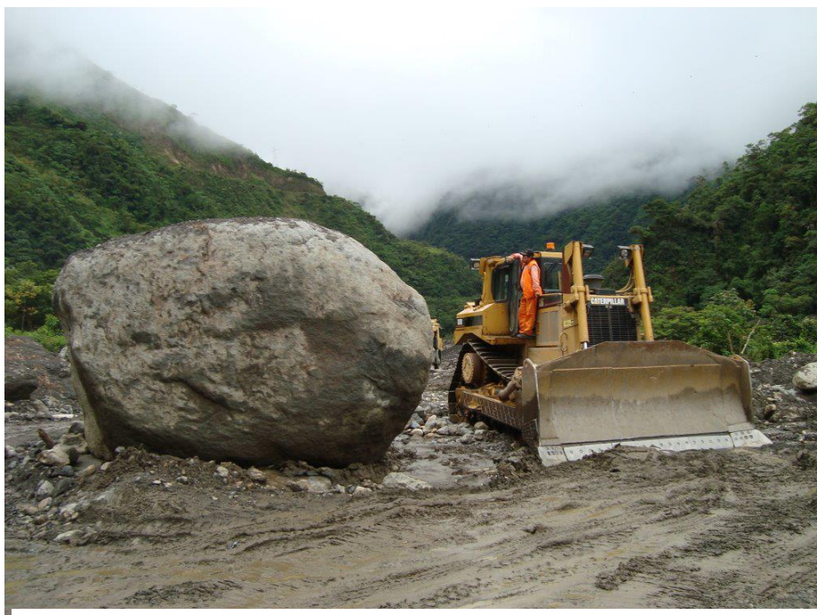
Foto 9. Sector Casahuri, Quebrada Carmen, susceptible a flujo de detritos (huayco), Afecta tramo de carretera, Central Hidroeléctrica San Gabán – Poblado de San Gabán
