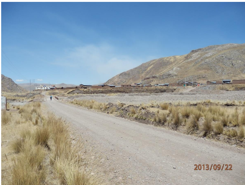
Foto 16. Vista panorámica del poblado de Larimayo susceptible a flujo de detritos, inundación y erosión fluvial, que afecta tramo de carretera y viviendas que se encuentran a la ribera del río.
