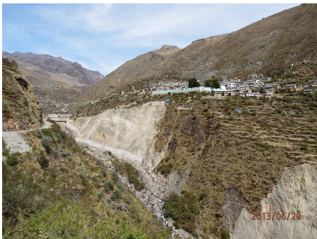
Foto 7. Sector Ccetapalo - quebrada Cancapunca, susceptible a derrumbes. Detonadas por las intensas lluvias. Afectaría viviendas que se encuentran al borde de la quebrada.
