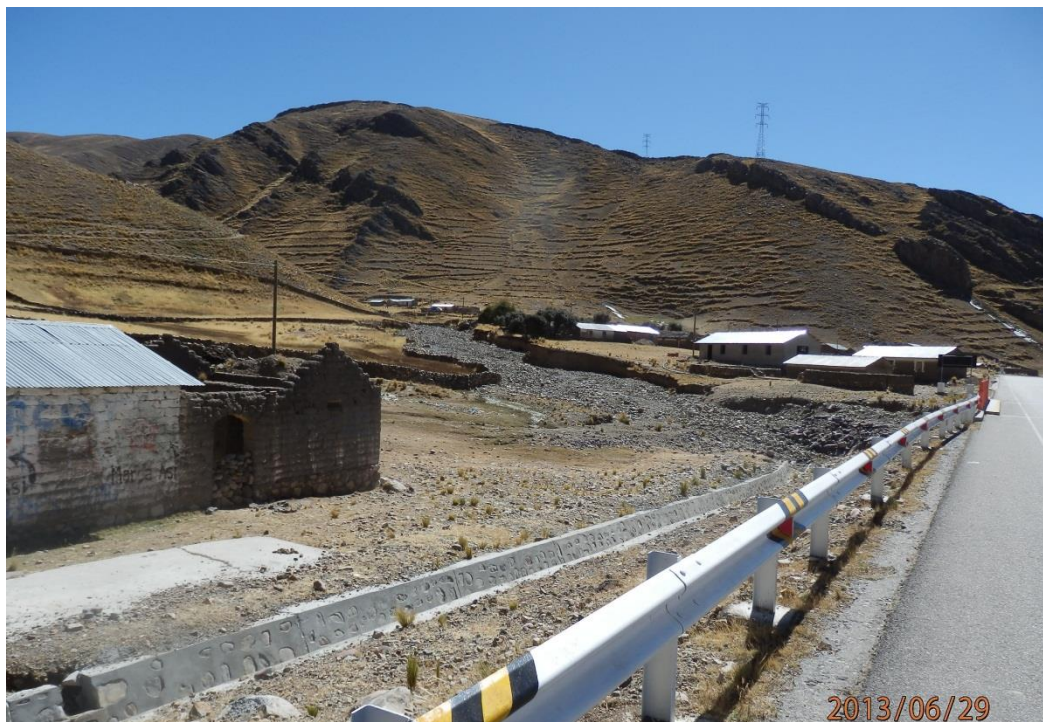
Foto 1. Sector Ccatuyo, susceptible a flujo y erosión. Afectaría viviendas que se encuentran asentados dentro del abanico antiguo.
