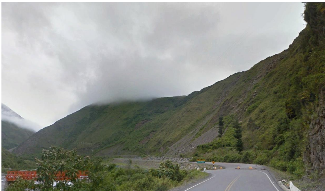
Foto 6. Sector Michinichi, susceptible a derrumbes. Detonadas por las intensas lluvia que presenta el sector. Afecta tramo de carretera Ollachea – San Gabán.
