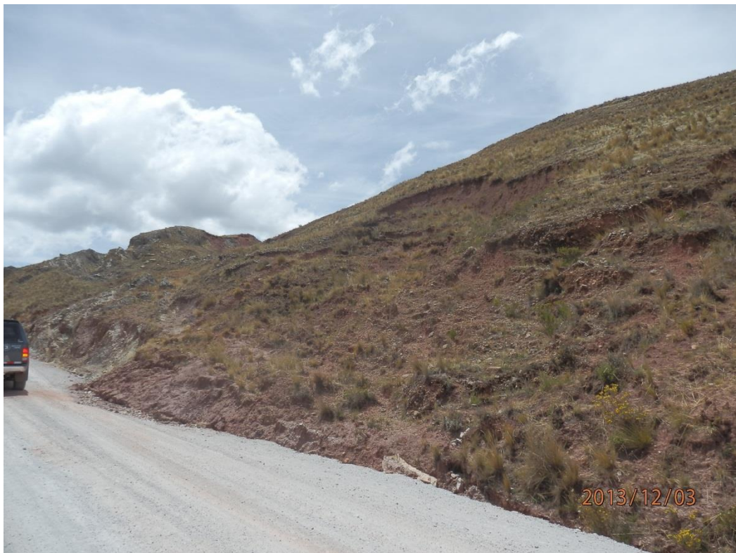
Foto 11. Vista de deslizamiento en el sector de Singum Camana, afecta tramo de carretera,
