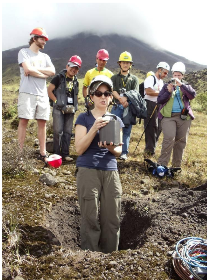
Foto 2.- Instalación de una estación sísmica GURALP en el Volcán Arenal.
