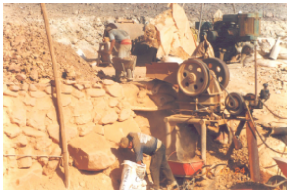
Vista que muestra operación de chancadora de quijadas (mina Paraíso-Tulin).
