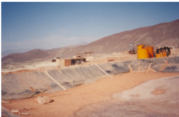
Poza de apilamiento y lixiviación del material-mina Ingenio.
