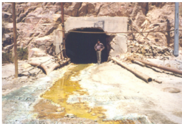
Drenaje ácido de roca a través de galería principal de servicios-mina Chapi.
