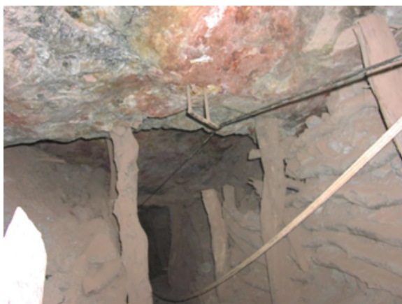
Vista que muestra el sostenimiento de la caja techo con puntales de madera de huarango-mina Sol de Oro-Nasca.
