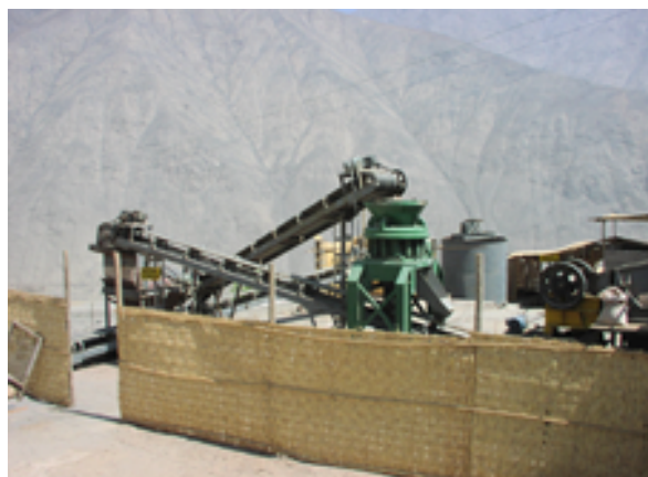
Vista que muestra la planta de tratamiento de minerales de oro de la Sociedad Minera Santa Filomena.
