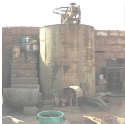
Tanques de agitación en la planta piloto (Parque Industrial-Arequipa).
