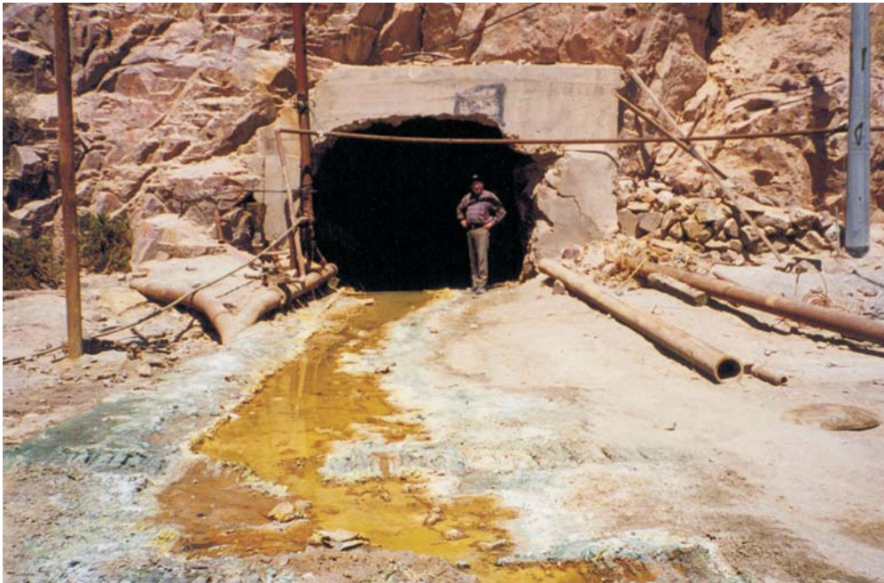
Foto N° 42 Efluentes líquidos residuales de interior mina. Mina Chapi - Arequipa
