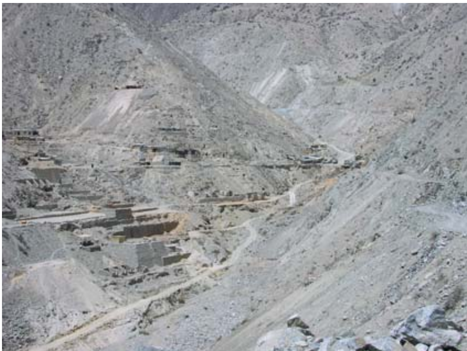
Foto N° 31 Vista de operaciones antiguas en actual recuperación por mineros artesanales. La mineralización está emplazada en rocas granodioríticas de las Super Unidad Tiabaya. Este sistema de vetas auríferas es explotado por mas de 500 mineros artesanales.
