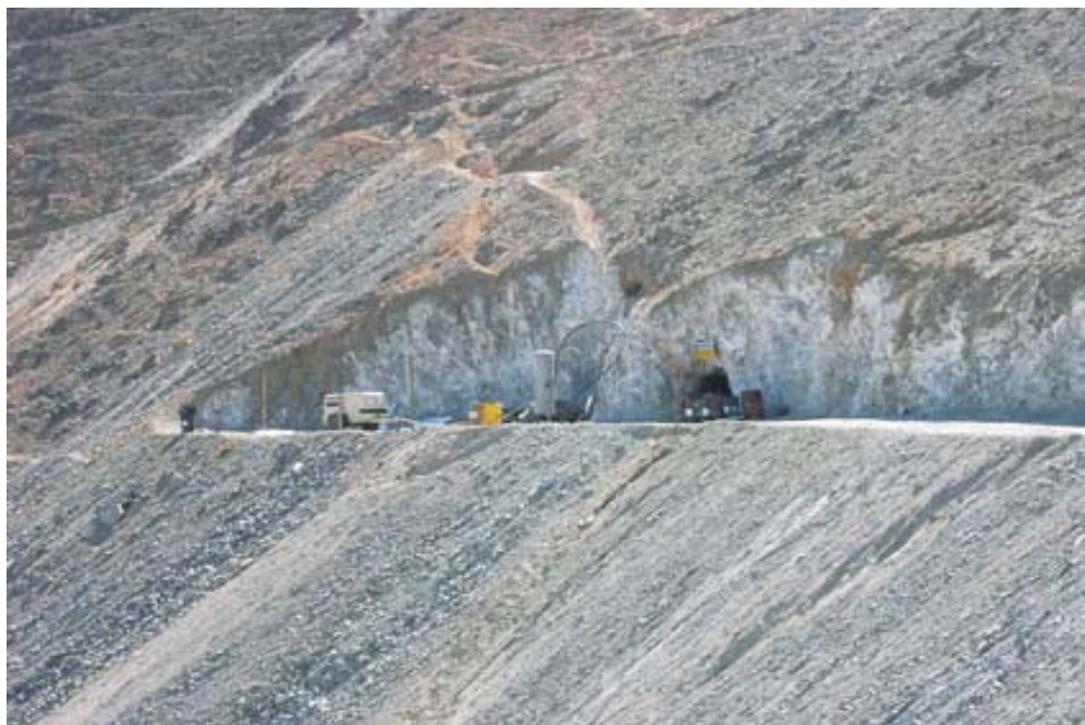
Foto N° 27 Parte alta de la mina capitana. Actualmente rehabilitada y trabajada por la Cia Minera Caravelí, la estructura tiene hasta 0,55 m de potencia y contiene cuarzo, pirita, oro y chalcopirita.
