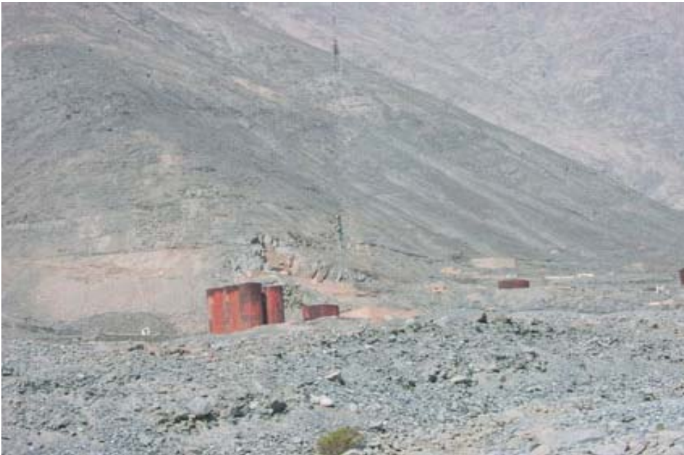
Foto N° 24 Planta de San Luis en quebrada Jaquí. Notese la estructura principal. En la parte baja, la planta de tratamiento (abandonada).
