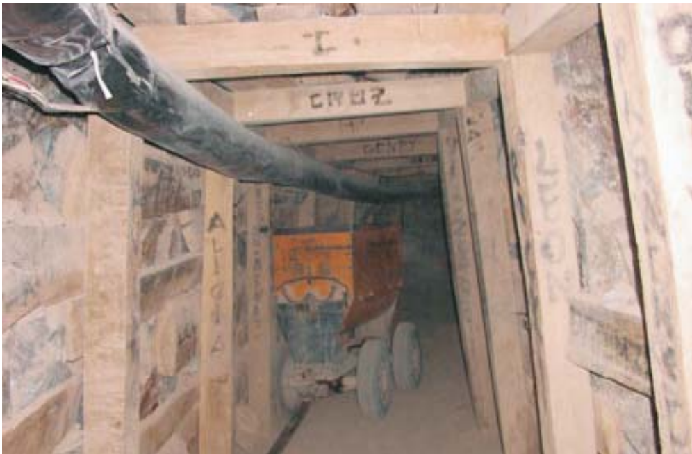
Foto N° 12 Galería principal con sostenimiento de cuadros de madera. Mina Cuatro Horas Cháparra
