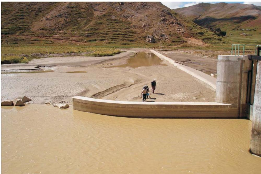
**Foto N° 15** Vista parcial de infraestructura de la bocatoma de la irrigación Progreso. Se observa la sedimentación de sólidos finos (Lamas) transportados de las nacientes del río Ramis y la turbidez de las aguas que comprenden el sistema de riego de la microcuenca Azángaro.
