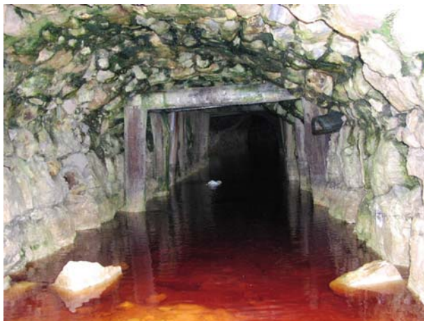
Foto 7 Drenaje de agua ácida en labores de minas abandonadas sector I – Cajamarca.
