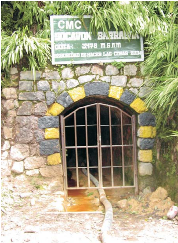
Foto 15 Mina Barragán (Hualgayoc). Toma de muestra de drenaje ácido en bocamina.
