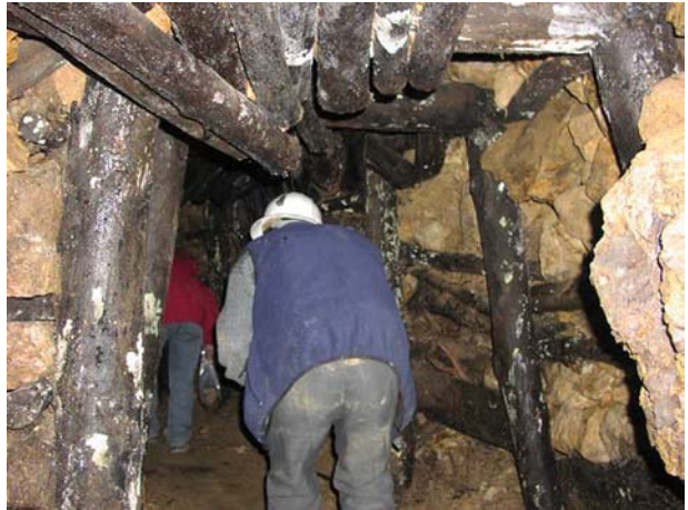
Foto 5 Se observa una sección de 0,8 x 1,20 m para galerías de acceso y operación.
