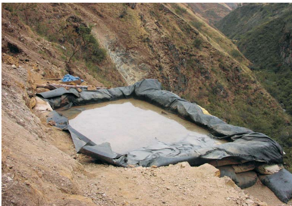
Foto 13 Pequeña poza de cianuración ubicada en una zona altamente vulnerable
