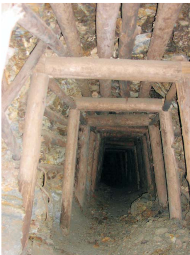
Foto 34 Mina Calavera, galería de acceso muy bien llevada (Pallasca Ancash)
