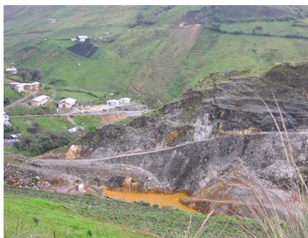
Foto 17 Vista de la Mina Los Colorados. Evidente acumulación de agua ácida, producto de la alteración de la roca.
