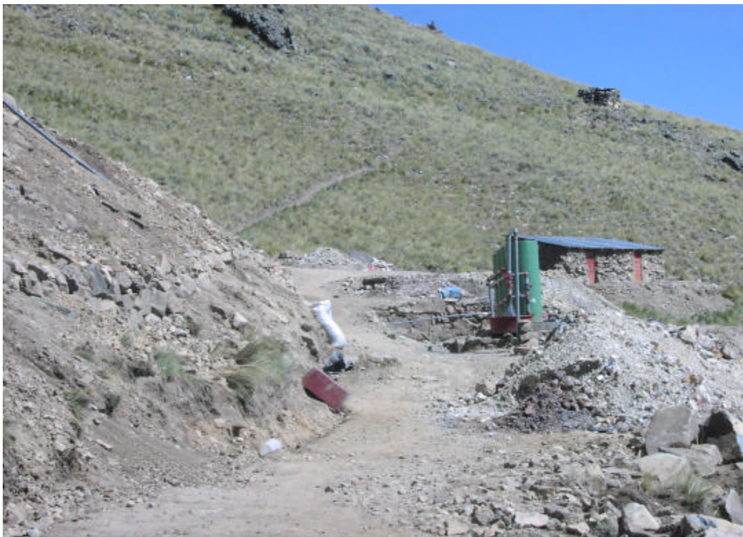
Foto 38. -Preparación de planta para tratar mineral por el método de cianuración en columnas - Kimsachata.
