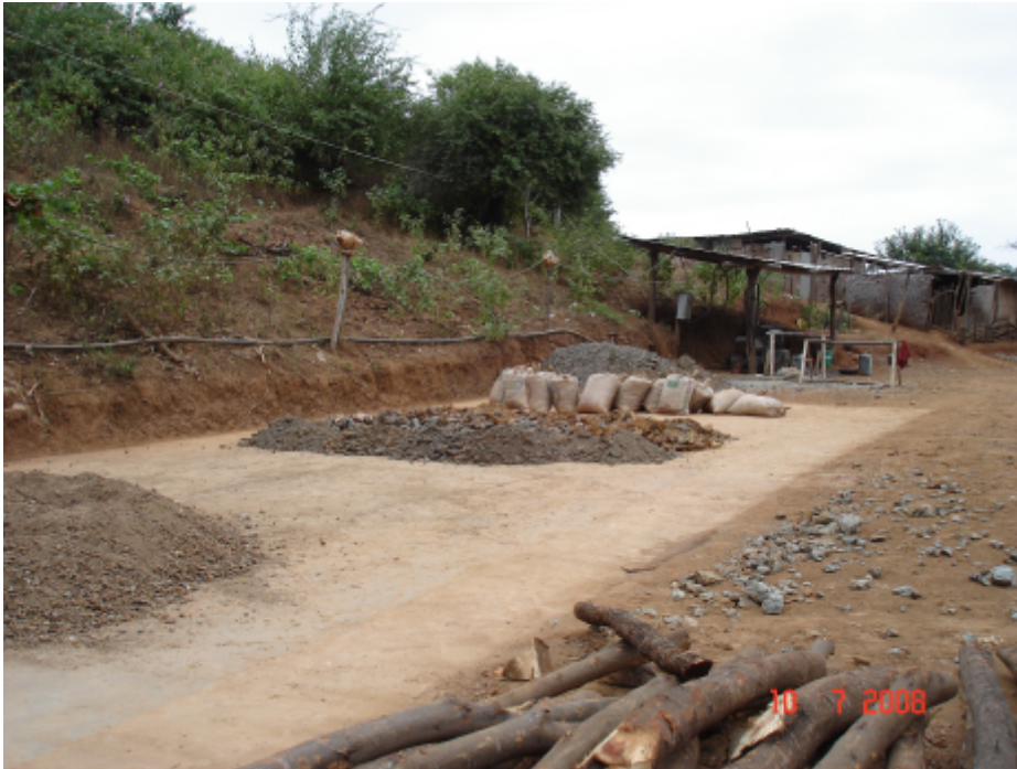
Foto 4.25 Plataforma de concreto para preparación mecánica manual, clasificación manual y disposición de mineral ensacado (sector San Sebastián).
