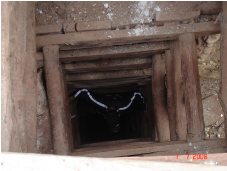
Foto 3.8 Vista de planta de desarrollo de pique con enmaderado que estabiliza las paredes que garantizan el ingreso del personal y evacuación del mineral con sistema de poleas (sector Cuchicorral).
