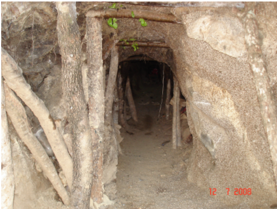
Foto 3.7 Vista frontal de sostenimiento con puntales y cuadros de madera de la zona, en ambiente de intrusivos alterados (sector Servilleta).
