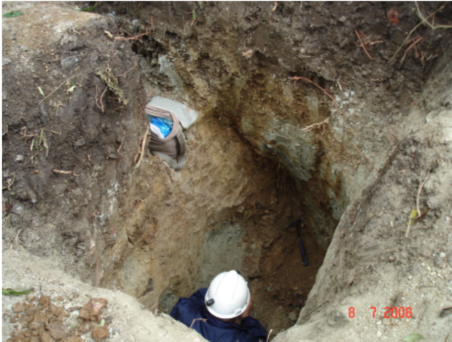
Foto 4.14 Disposición de pique de acceso y extracción de mineral estabilizado con madera en ambiente altamente alterado (sector Cuchicorral).
