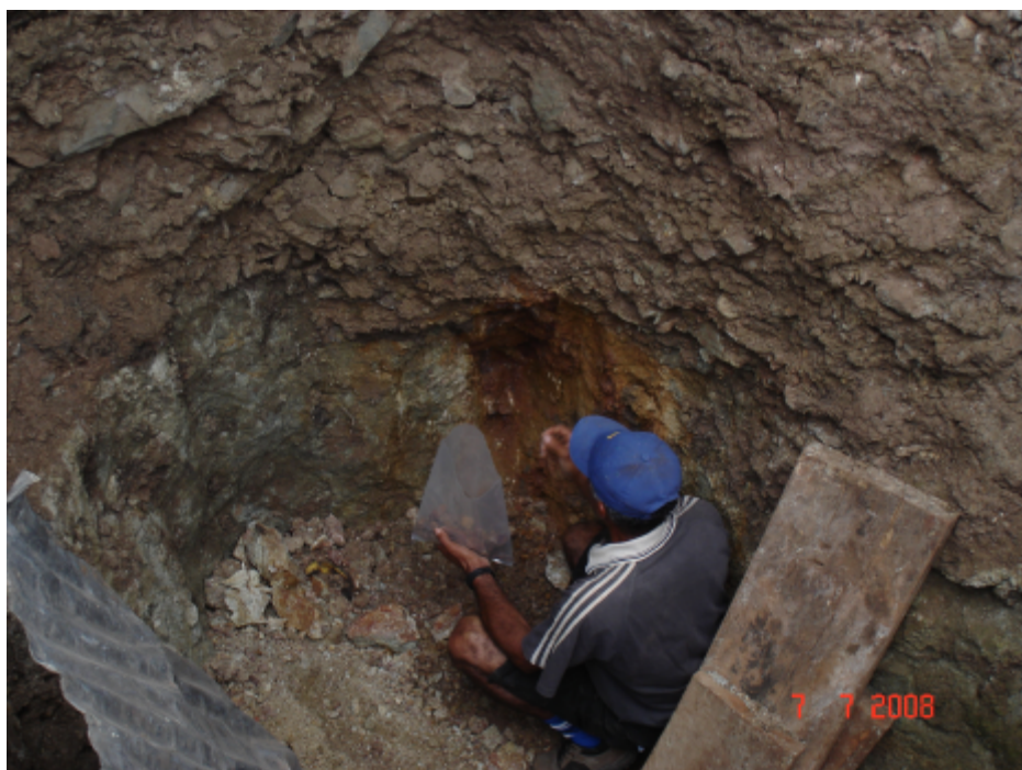
Foto 4.8 Muestreo de estructura mineralizada en ambiente de intrusivos alterados (sector Cuchicorral).
