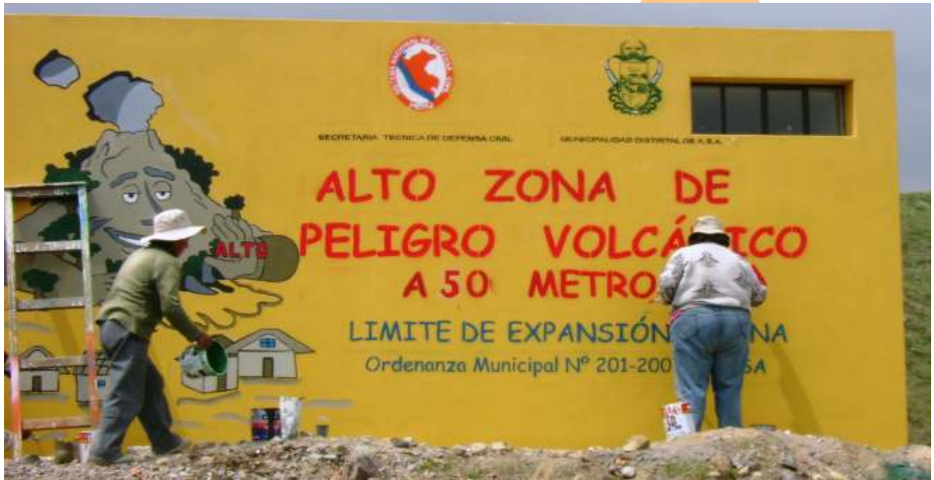
Padres de familia pintando muro sobre el limite de expansión urbana bajo la ordenanza Municipal en ASA.
