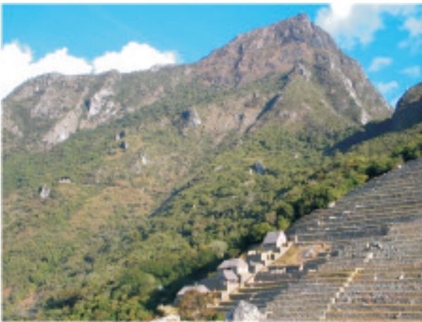
Foto 6. Reptación que afecta a las terrazas agrícolas
