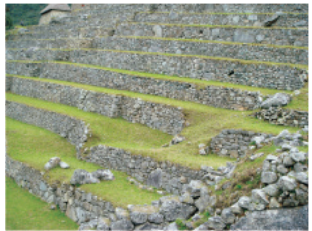
Foto 5. Deslizamiento en el cerro Machupicchu
