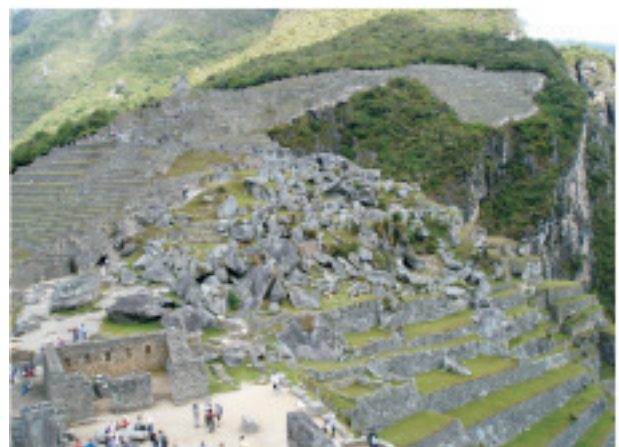
Foto 1. Caos granítico sobre el que fue construido la ciudad. En este sector no se culminó con la estabilización.
