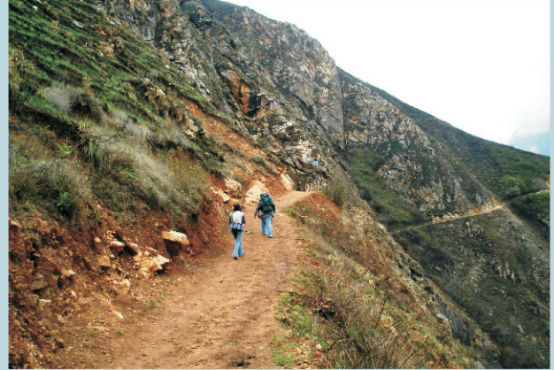
Camino afectado por derrumbes y erosión superficial en Waywacalle.
