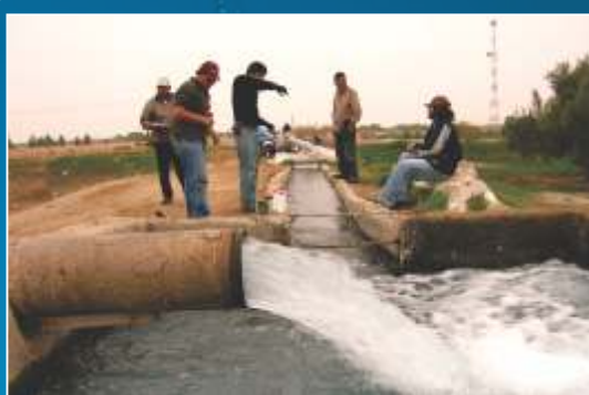
Foto 1. Sondeo de captación en acuíferos porosos no consolidados. Vista del acuífero La Yarada, Región Tacna.
