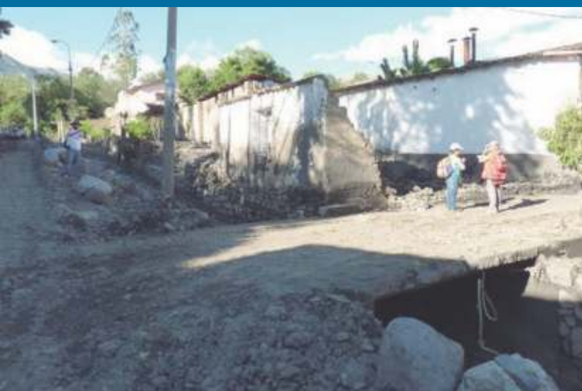
Fotos 1 y 2. Dos fotos de la afectación, producto de la avalancha-flujo de detritos del cerro Chuyllurpata. Destrozo de pared de vivienda y vehículo cubierto por material de la avalancha.
