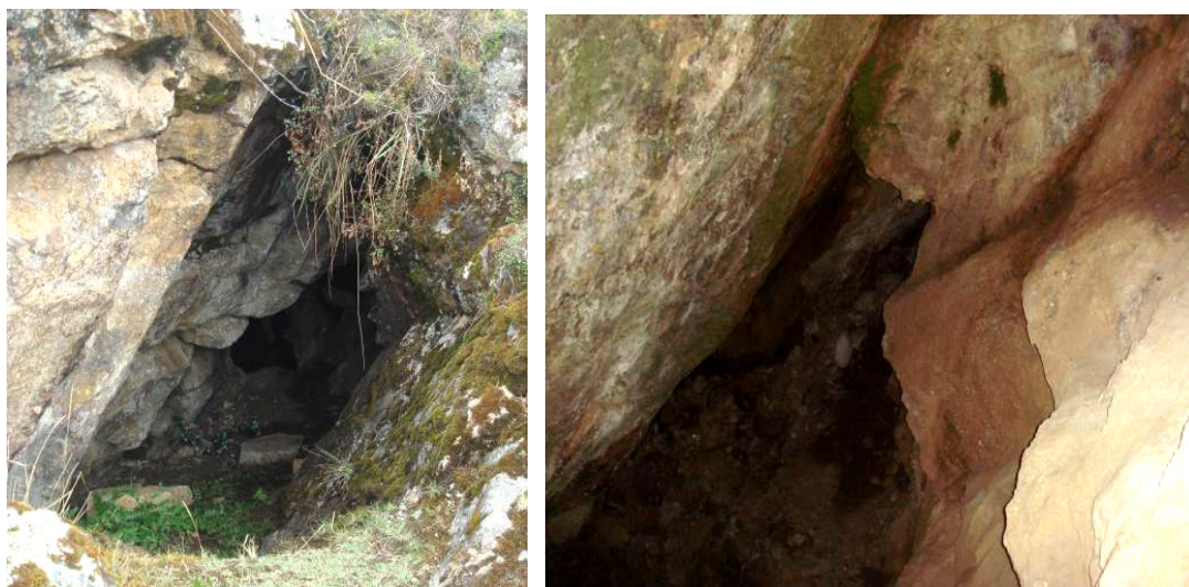
Figura 3.4.- Vistas de las labores abandonadas en la mina Quishhwarhuayco.
